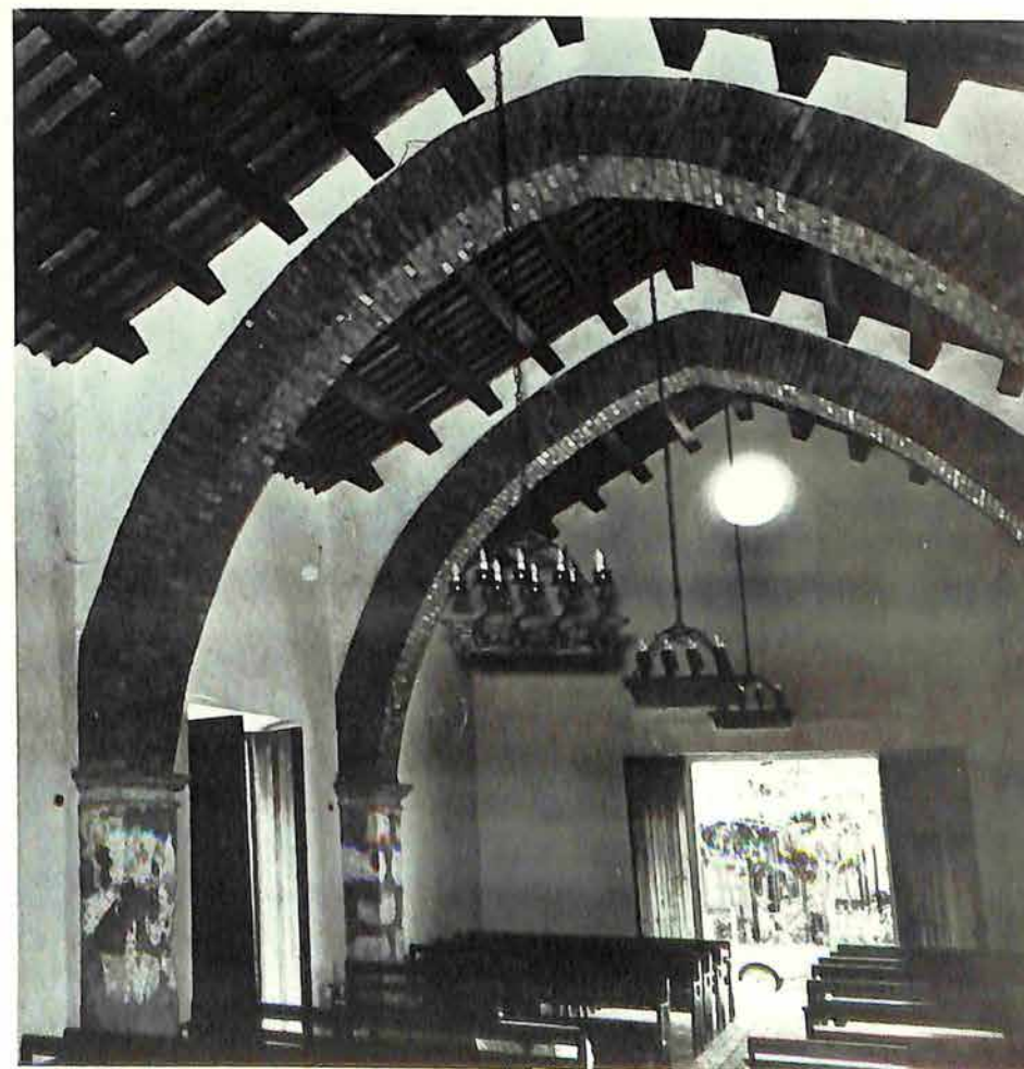
Interior de la ermita de San Lorenzo de Los Minas, donde pueden observarse los arcos ojivales de ladrillos sobre las pilastras adosadas.
