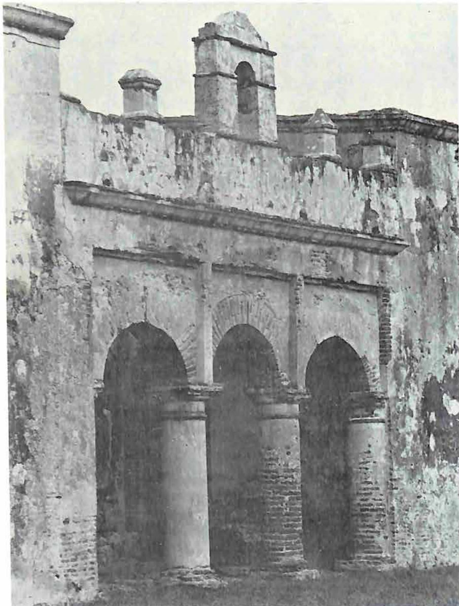
Espadaña de Ladrillo.
