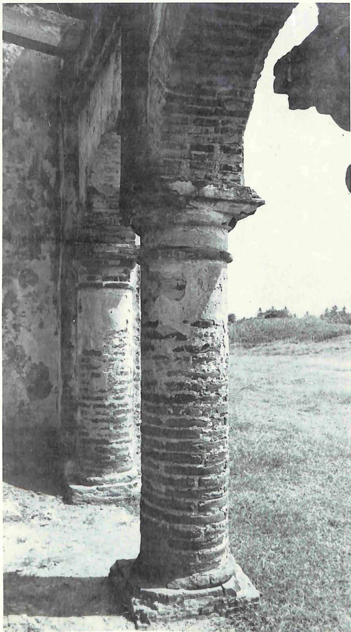
Detalle de las columnas del pórtico de la casa de Palavé.
