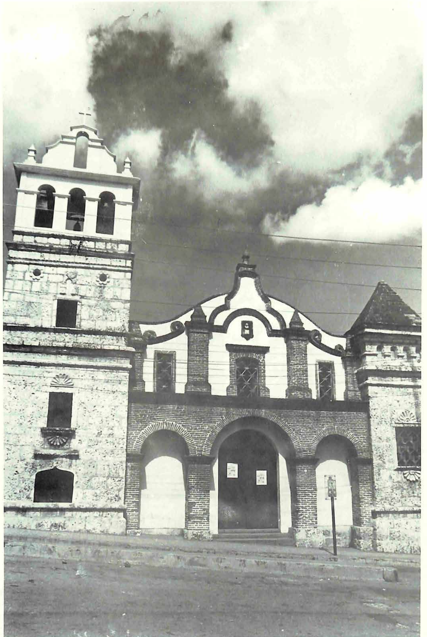
Fachada de la Iglesia de Santa Bárbara después de su restauración.
