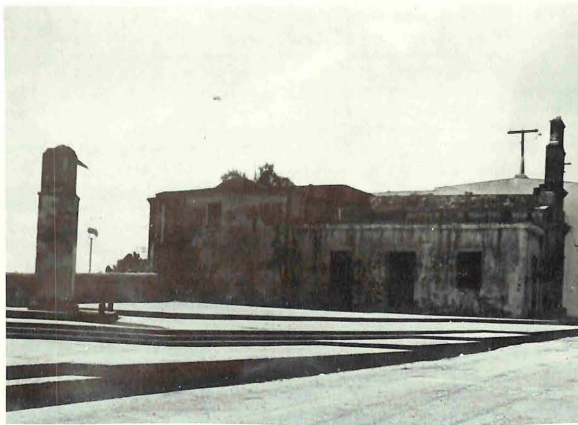
Imagen del entorno inmediato a la capilla en la cual se destaca en primer plano el reloj del sol
