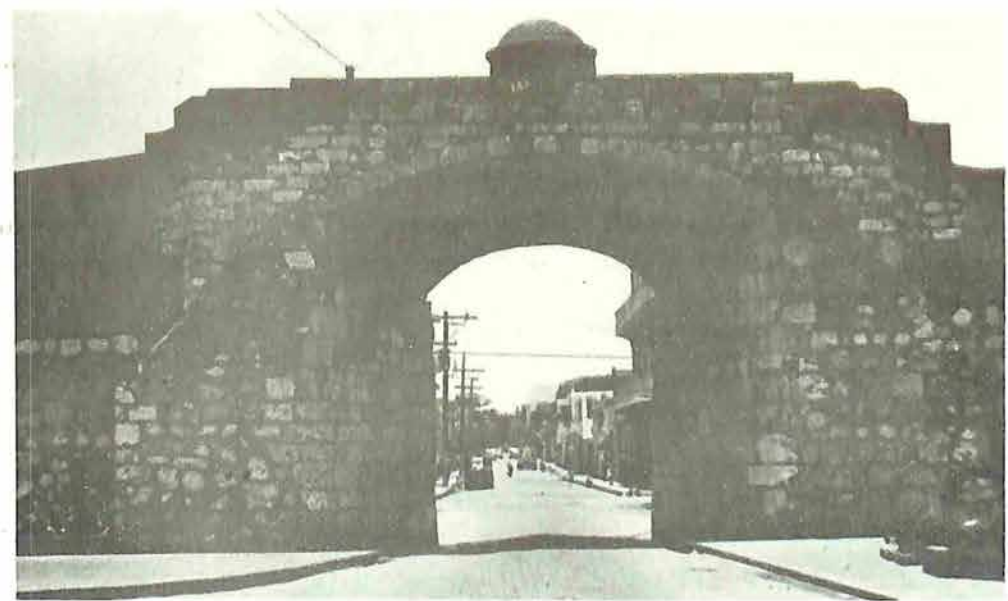
Puerta de la Misericordia, Puerta Grande o de la Sabana, desde el interior de la ciudad
