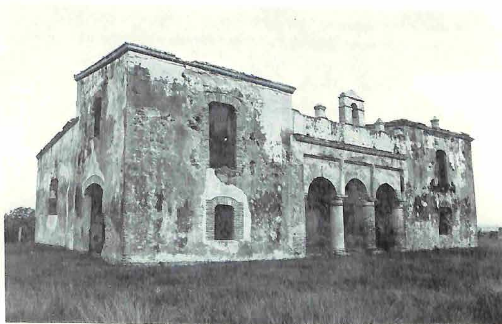
Vista general de la casa.
