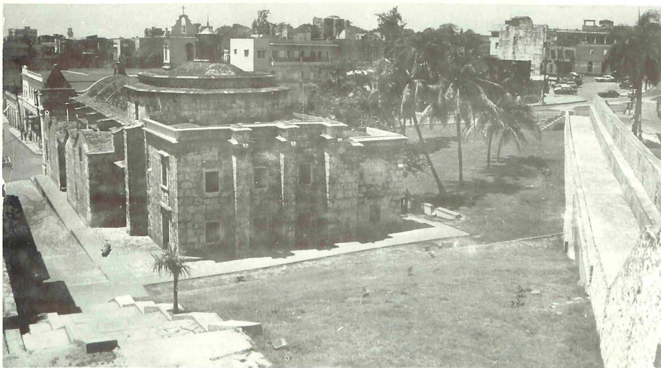
Vista General de la Iglesia y su entorno desde el Baluarte.
