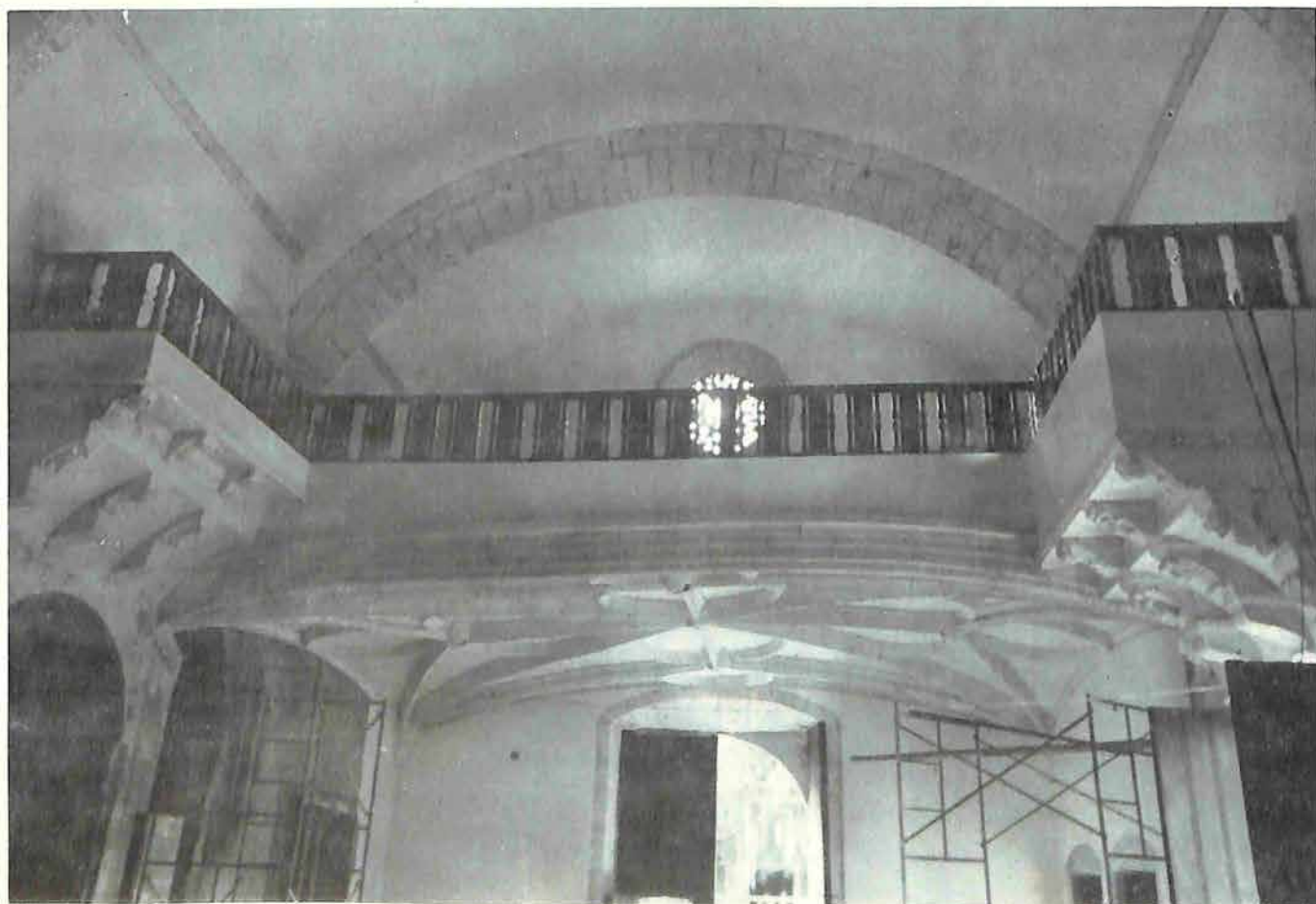
El Coro alto , después de su restauración, el cual constituye una expresión refinada, de atrevida estructura, que descansa sobre un arco rebajado con bóveda de crucería prácticamente plana.
