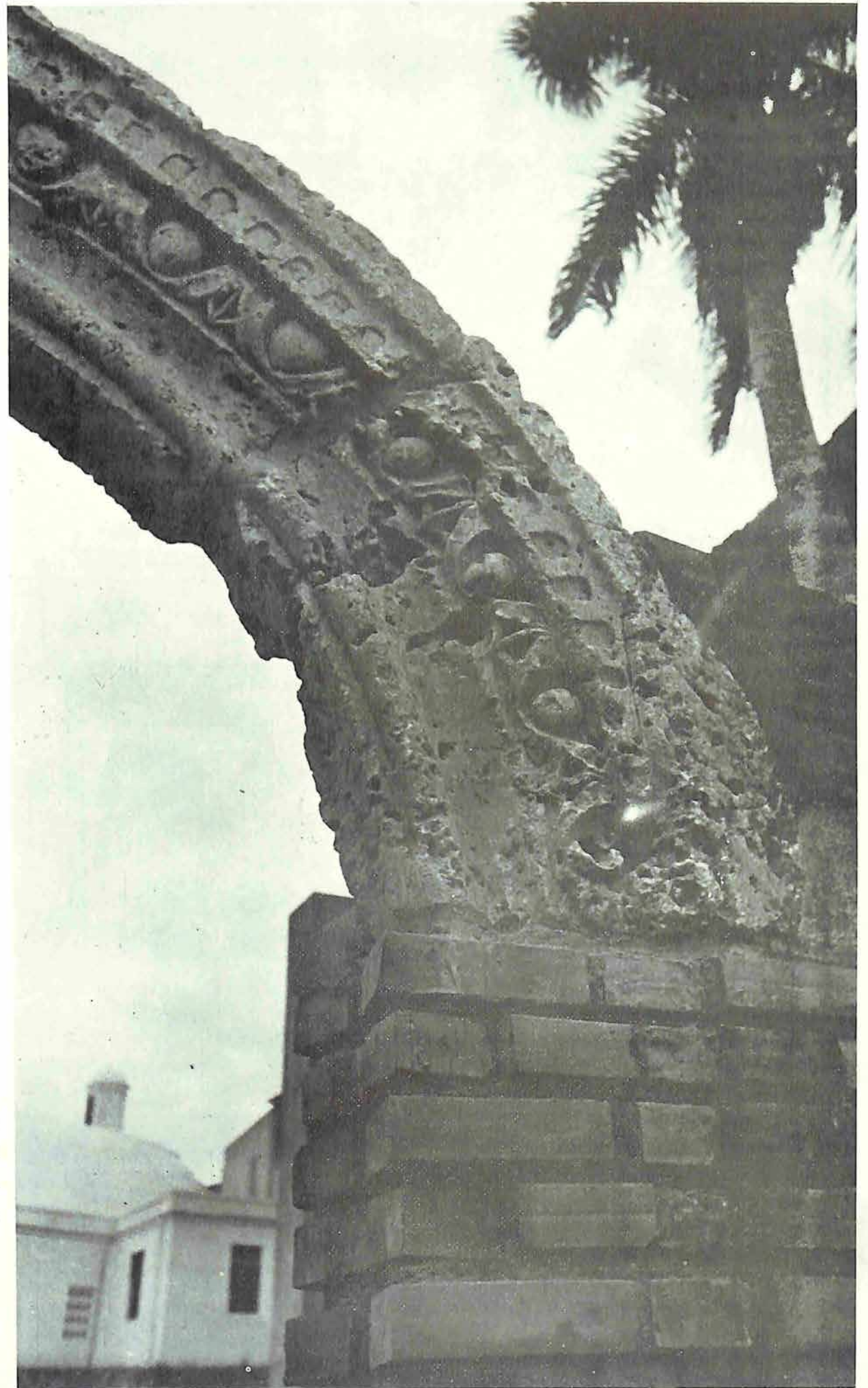
Detalle de arco de piedra recompuesto en el Hospital de San Nicolás.
