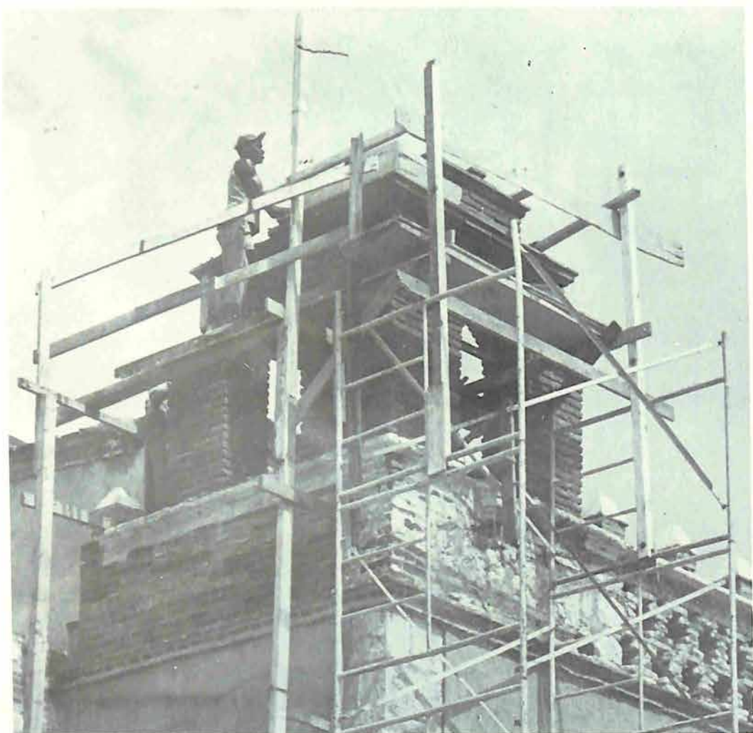
Proceso de construcción de la espadaña de la Iglesia. Nótese en la primera fotografía la arcada descubierta en la fachada Este.
