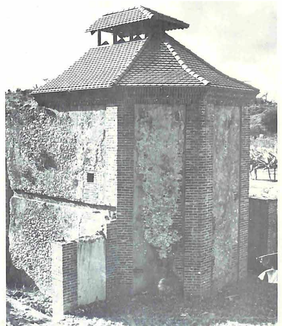
Depósito o Secadero después de la restauración.
