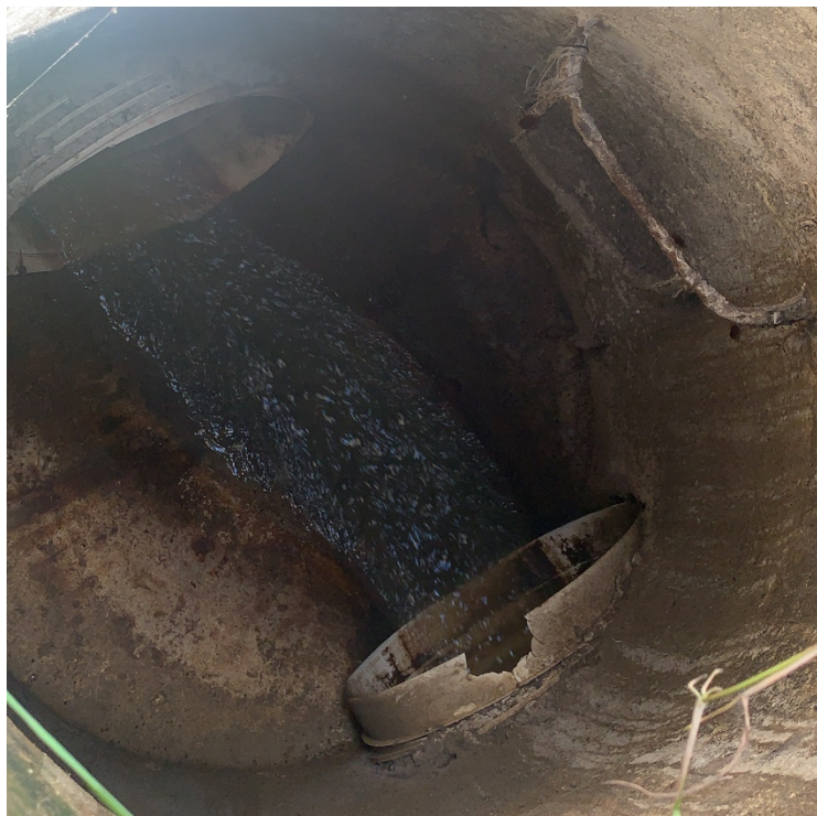
Ilustración 14: Vista del interior del registro del alcantarillado sanitario
