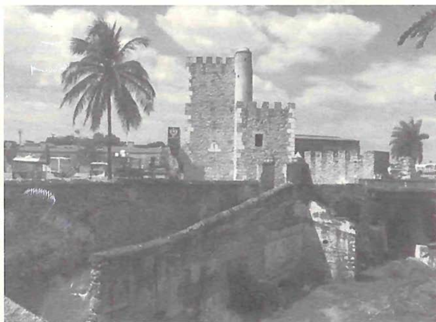
Vistas del conjunto de la Fortaleza de Santo Domingo. (Fotos M. Arq. Esteban Prieto Vicioso).
