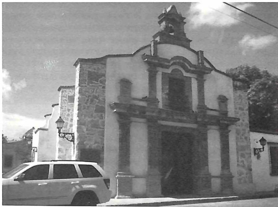
Vista general de la capilla después de la restauración.
