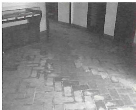
Reposición del piso de losetas de barro, levantados para el soterrado de las tuberías, colocados siguiendo la disposición del diseño existente.
