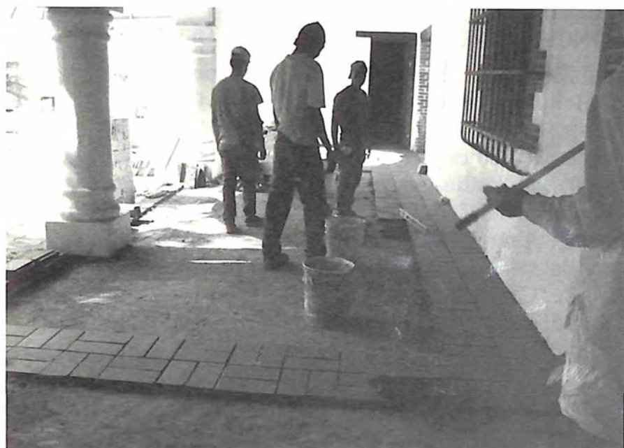
La galería ya con el vaciado de la torta de hormigón armado e iniciada la instalación de los pisos.
