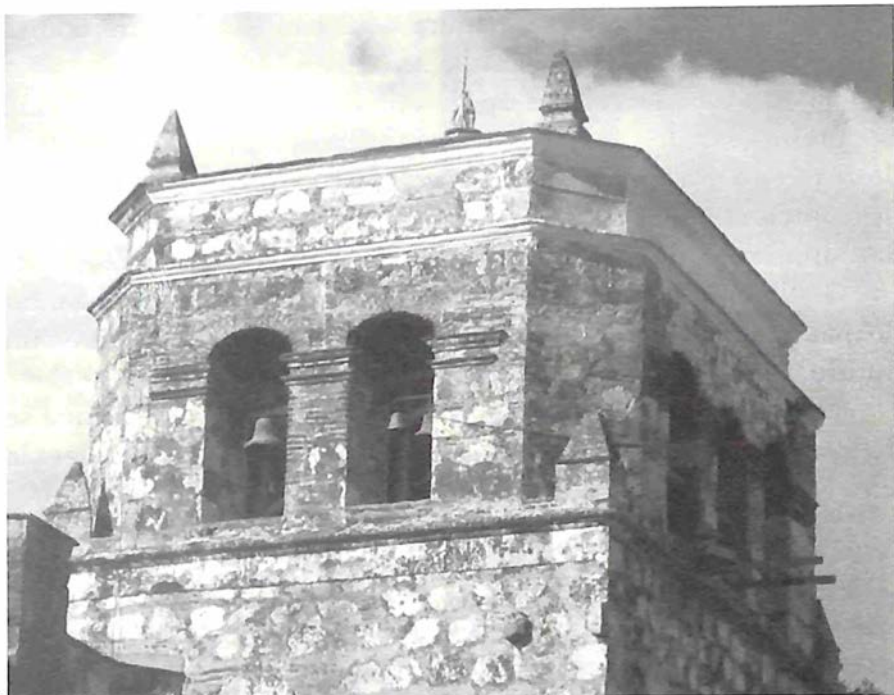
Vista de la torre del campanario una vez finalizados los trabajos.
