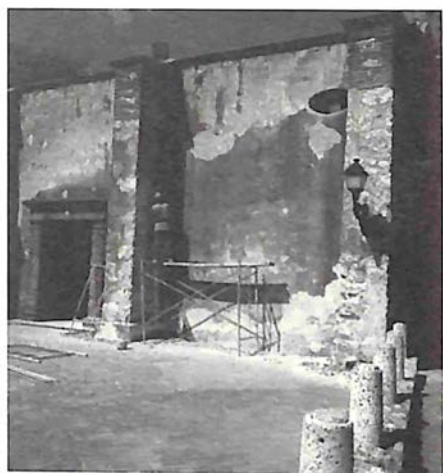
Proceso de trabajo en los pañetes de la fachada este.
