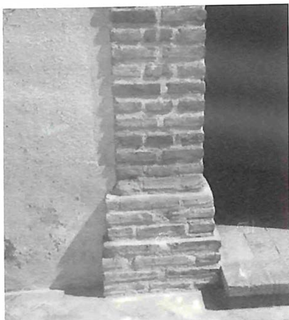
Se observan las pilastras del portal este después de los trabajos.
