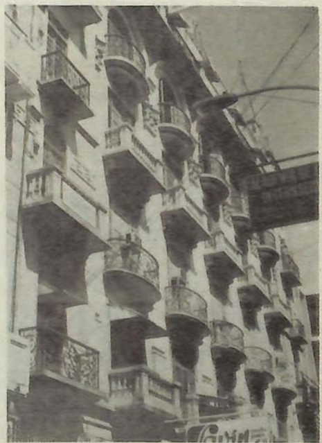
Edificio Díez. Benigno Trueba, Santo Domingo.
