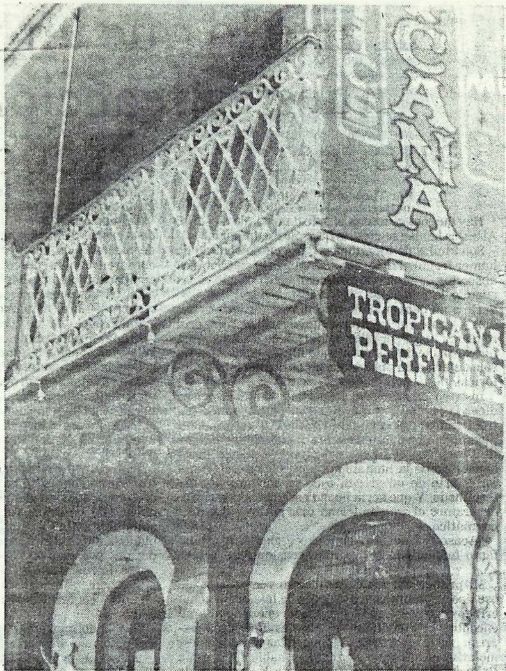
Los balcones de las casas en St. Thomas integran el hierro, la madera, el ladrillo altos techos de tejas de barro y sofisticadas ménsulas.
