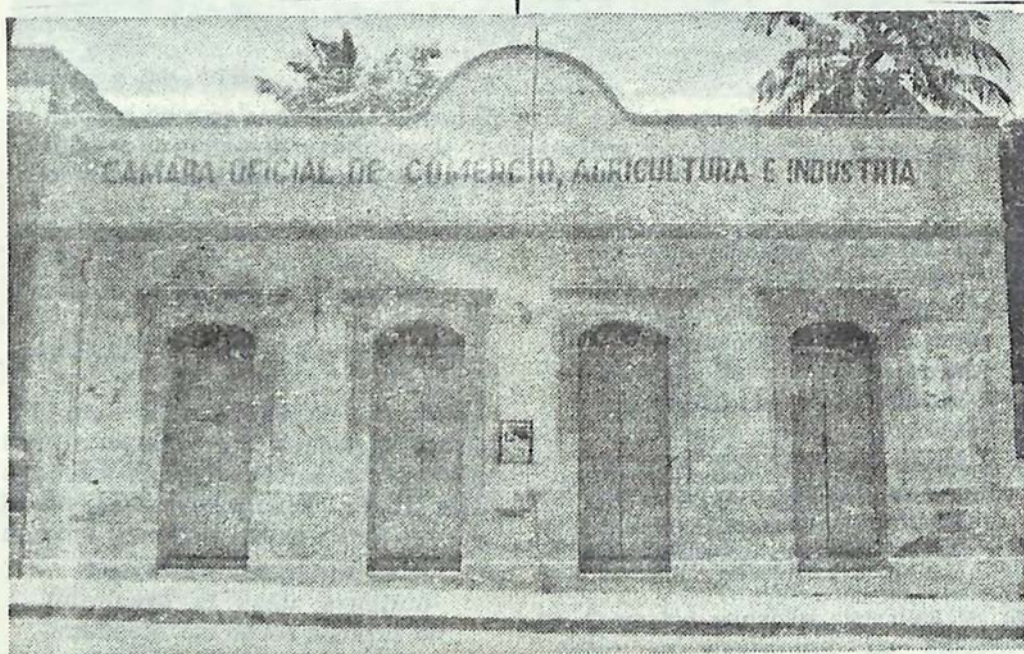
Casa de mampostería recubierta. Los vanos de las puertas están destacados por un marco neoclásico con cornisas, característico del eclecticismo de los años en que fue construido.
