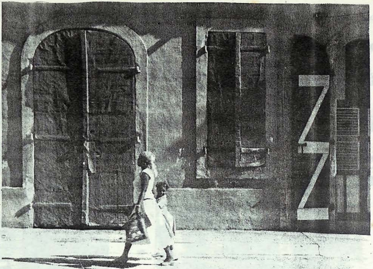
El arco rebajado, los detalles enmarcando aperturas; planchas metálicas reforzando seculares portales. El exámen de estos elementos tradicionales arroja interesantes enseñanzas al arquitecto contemporáneo. Cabo Haitiano, siglo XIX. (Foto: Ruth Connell, University of Florida. 1982)
