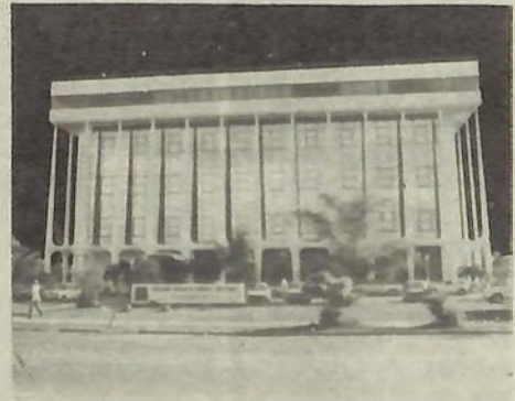
Edificio principal de la Asociación Popular de Ahorros y Préstamos. Arq. William Reid.
