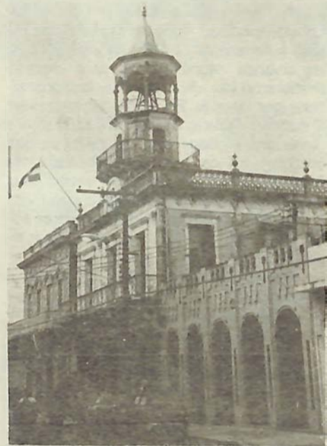
Edificio del Cuerpo de Bomberos, San Pedro de Macorís.
