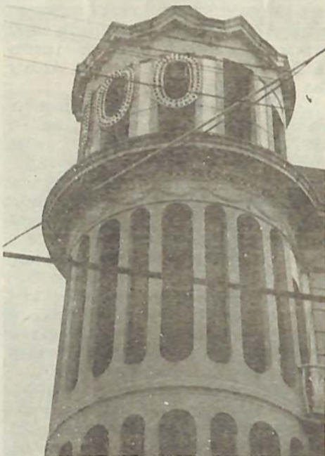
Torre esquinera del Edificio Morey.
