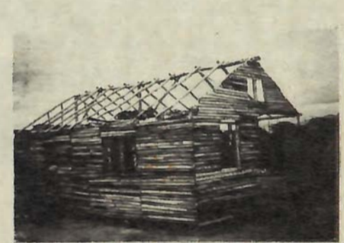
Estructura del techo.
