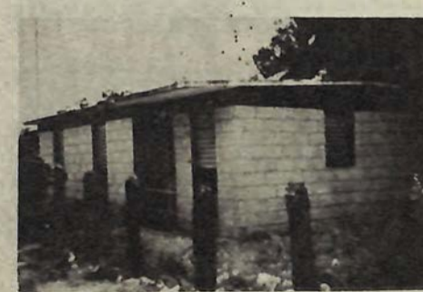
Entretreído de las paredes antes de aplicar el enlucido.
