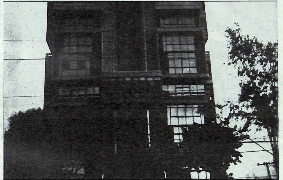
Edificio "Corominas-Pepín" Arq. José Mella
