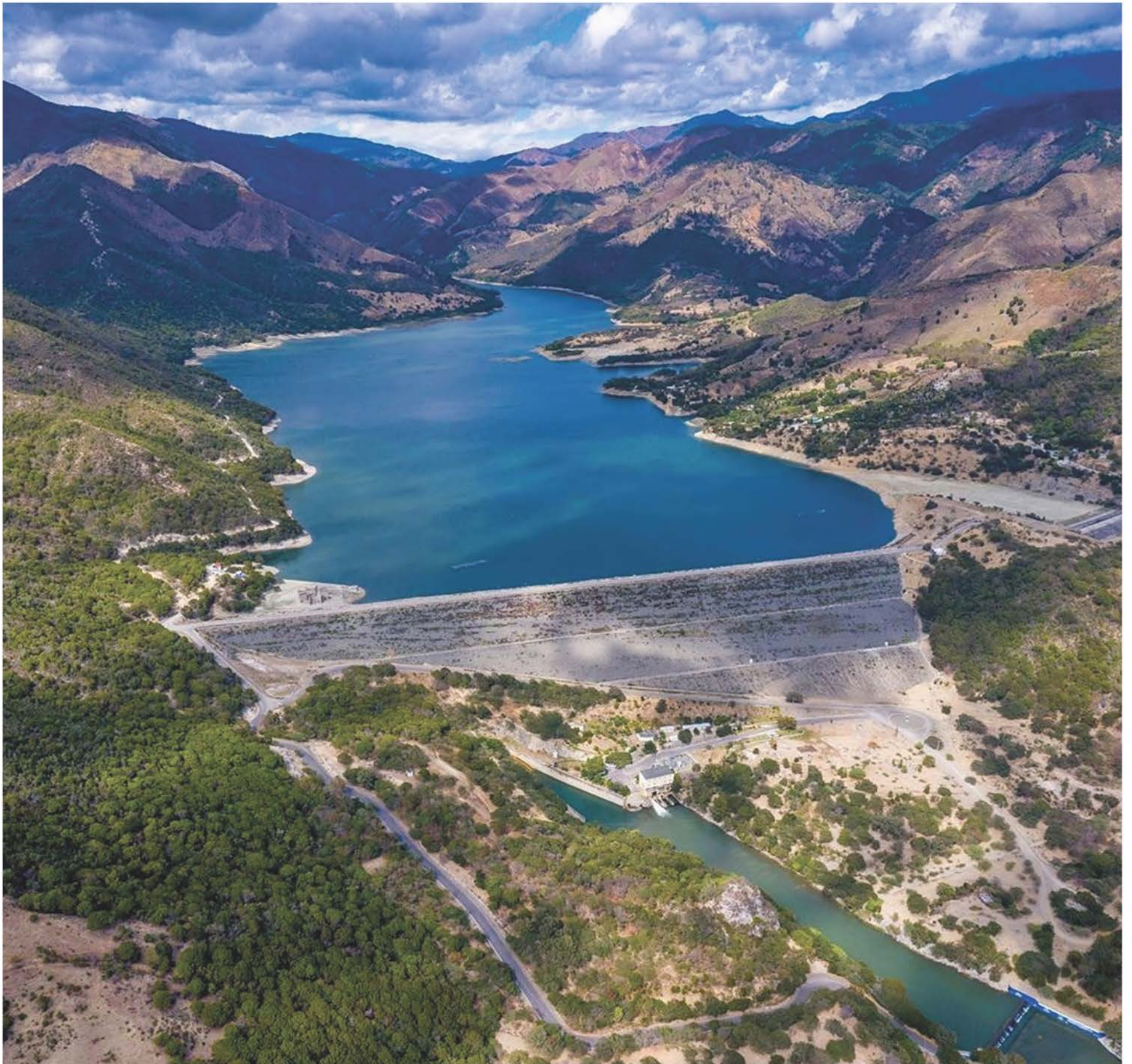
Figura 123. República Dominicana (2021). Visual Presa de Sabaneta.
