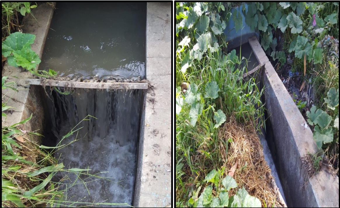
Figura 9: Condición Física de la Planta de Tratamiento de Constanza.
