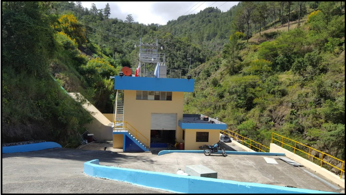
Figura 12: Planta Hidroeléctrica de la Planta de Tratamiento. Fuente: Planta de Tratamiento de Aguas Residuales, Constanza, Propia, 2016.
