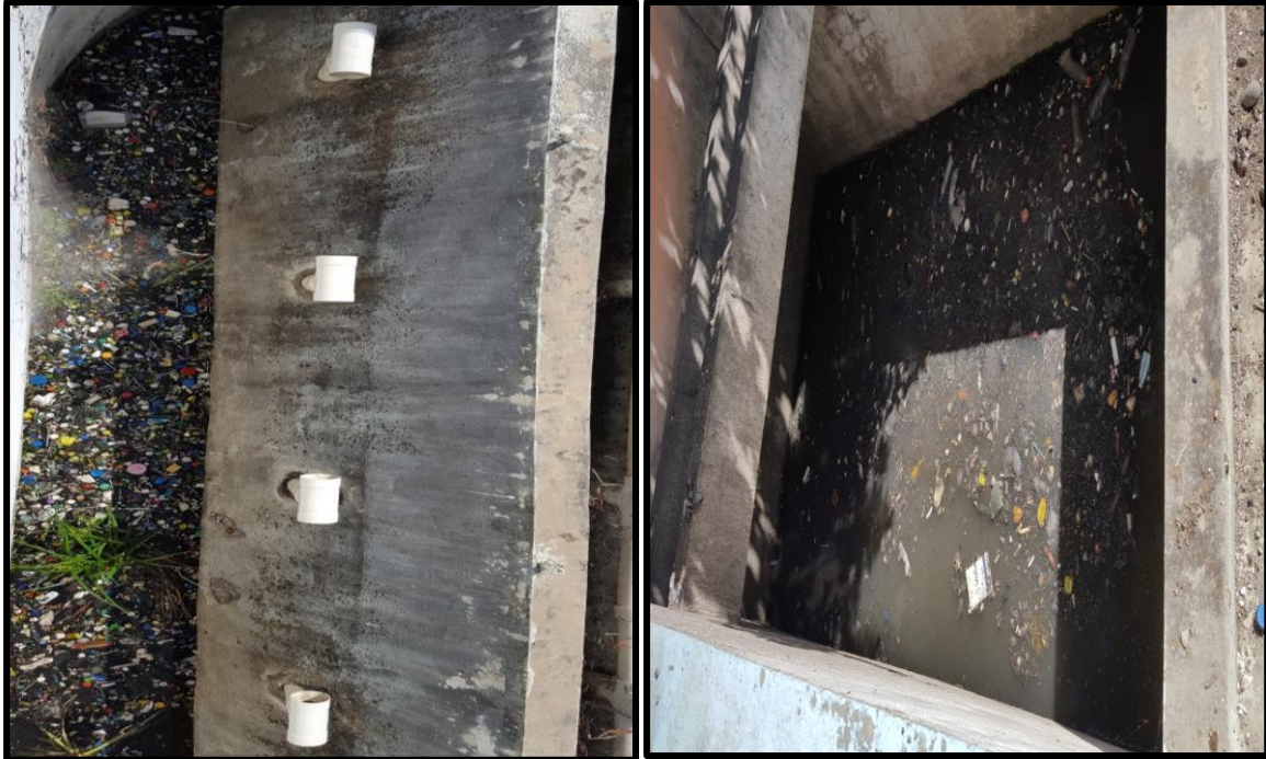
Figura 10: Condición Física de la Planta de Tratamiento de Constanza. Fuente: Planta de Tratamiento de Aguas Residuales, Constanza, Propia, 2016.
