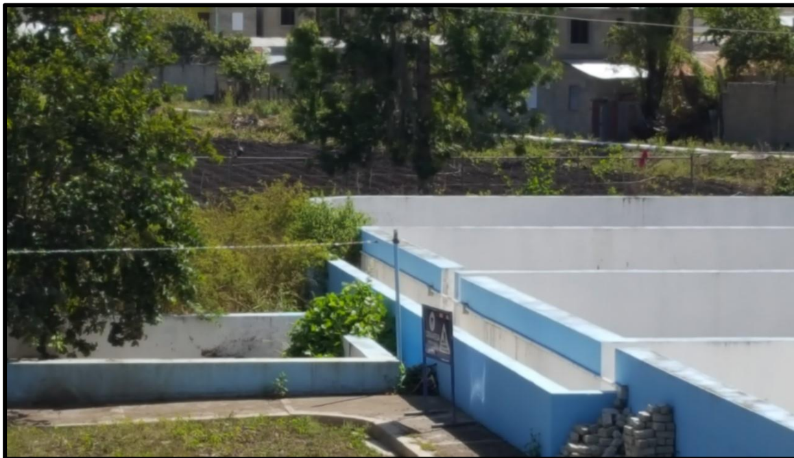
Figura 11: Reactores y Sedimentador de la Planta de Tratamiento de Constanza. Fuente: Planta de Tratamiento de Aguas Residuales, Constanza, Propia, 2016.
