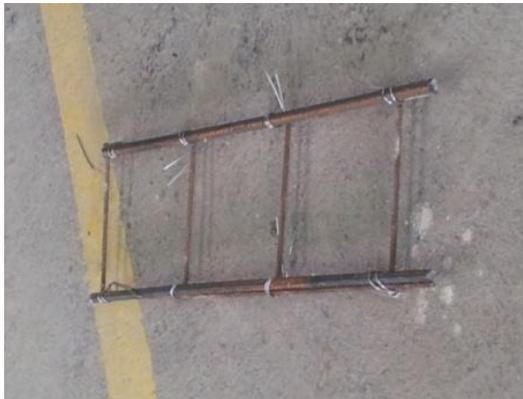
Figura 13: Colocación de acero en la armadura interna para viga de ferrocemento
