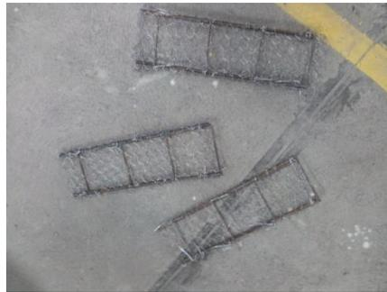
Figura 14: Colocación de tela gallinera en la estructura interna para viga de ferrocemento
