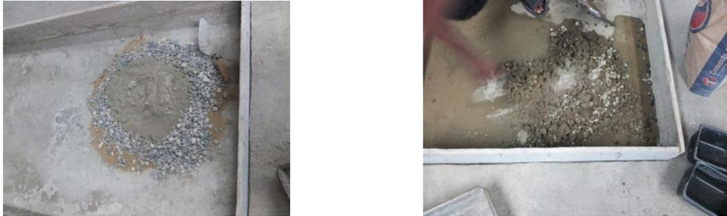
Figura 7: Preparación de la mezcla para viga de hormigón armado
