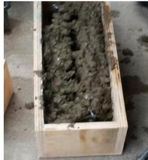
Figura 8: Colocación de la mezcla en el encofrado para viga de hormigón armado
