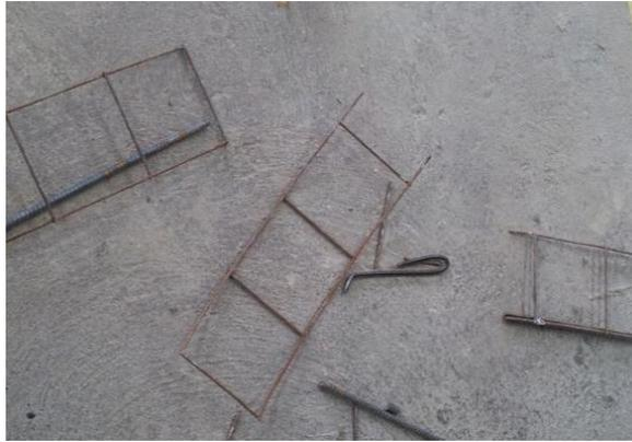
Figura 12: Preparación de la armadura interna para viga de ferrocemento
