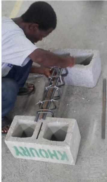
Figura 5: Preparación de la armadura interna para viga de hormigón armado
