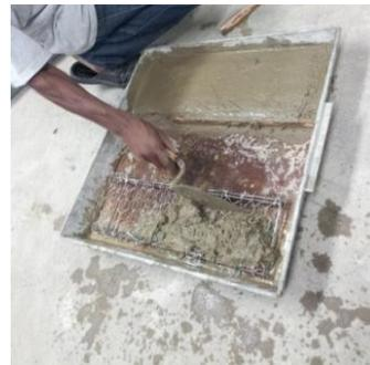
Figura 15: Colocación de la mezcla para viga de ferrocemento
