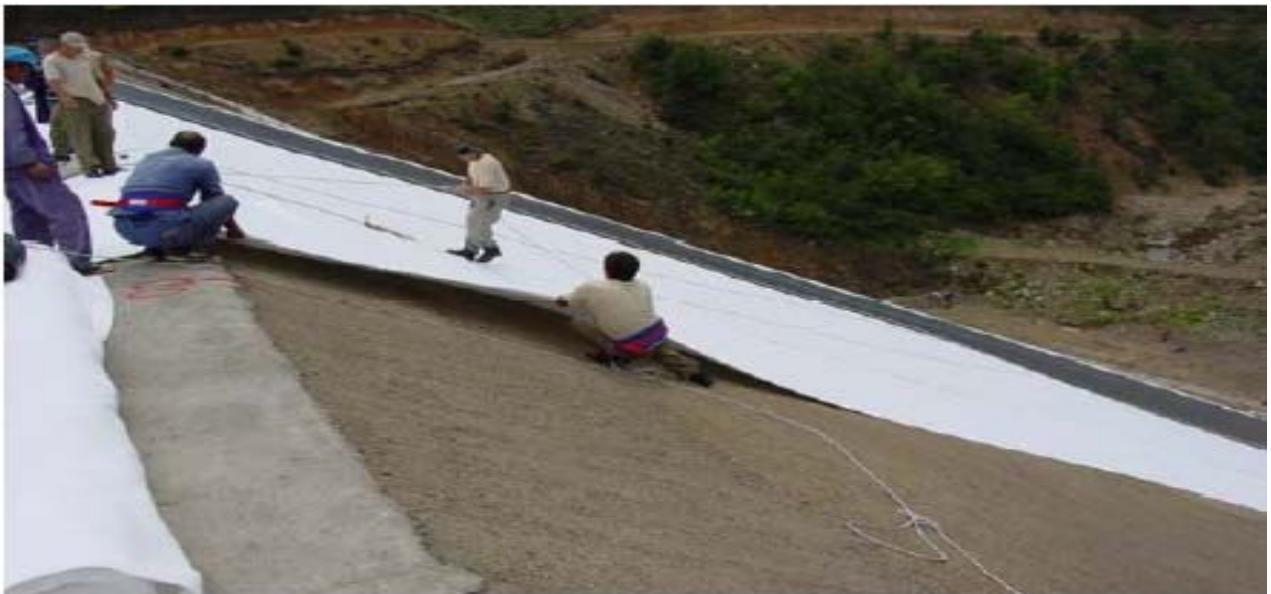
Ilustración 32. Colocación del geotextil. (RENOLIT Ibérica S.A., 2013)
