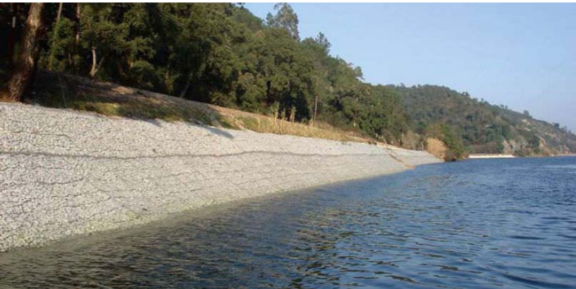
Ilustración 15. Protección con gaviones.(ArchiExpo)
