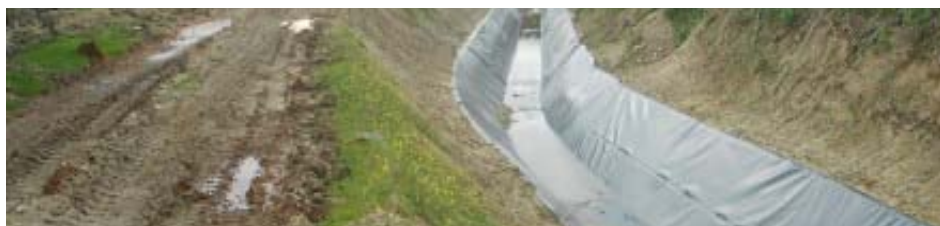
Ilustración 22. Colocación de la geomembrana en el canal de Montargil.
