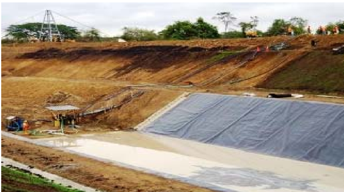
Ilustración 20. Proceso de revestimiento del canal de Daule – Río Nuevo en la provincia de Guayas, Ecuador.
