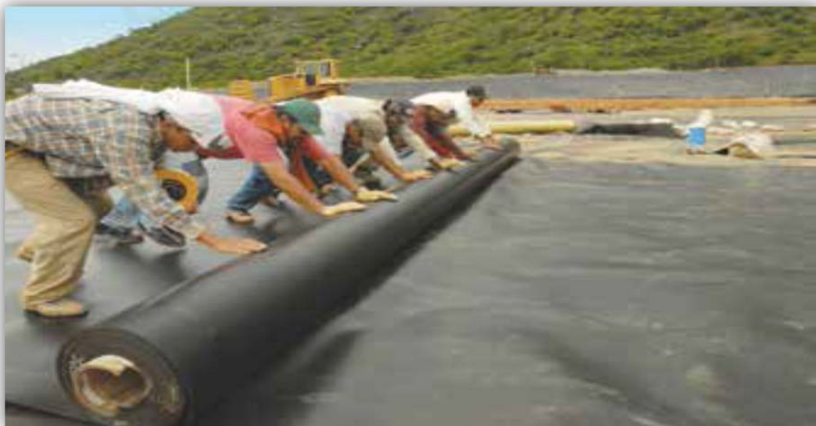
Ilustración 33. Relleno Sanitario Yotoco, Valle del Cauca, 2006 (HDPE 60 mils)
