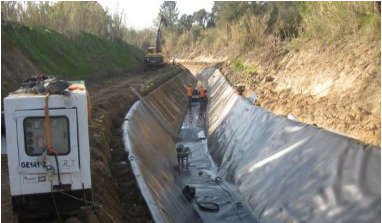
Ilustración 21. Mejoramiento del Canal Montargil, Portugal.
