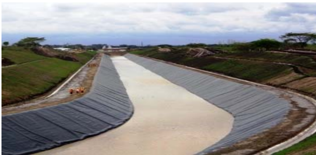
Ilustración 19. Terminación de revestimiento del canal Daule en Ecuador.
