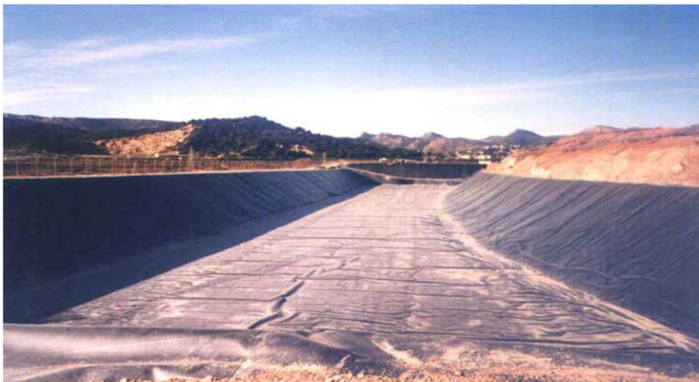
Ilustración 18. Canal recubierto con geomembrana. (Criar Peces)
