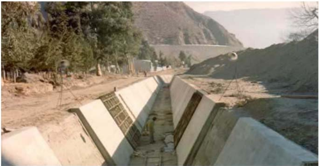
Ilustración 7. Canal artificial de Secciones transversales trapecial. (Ruiz, 2008)
