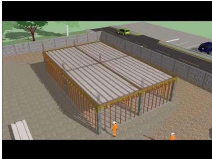
Ilustración 1-0-2-Losa Maciza (Panama)
