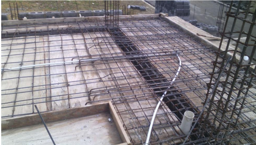
Ilustración 1-0-3-confección de losa maciza (Propia)
