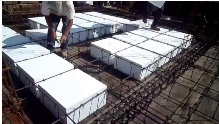
Ilustración 1-0-2- Losa Nervada (Rodero)
