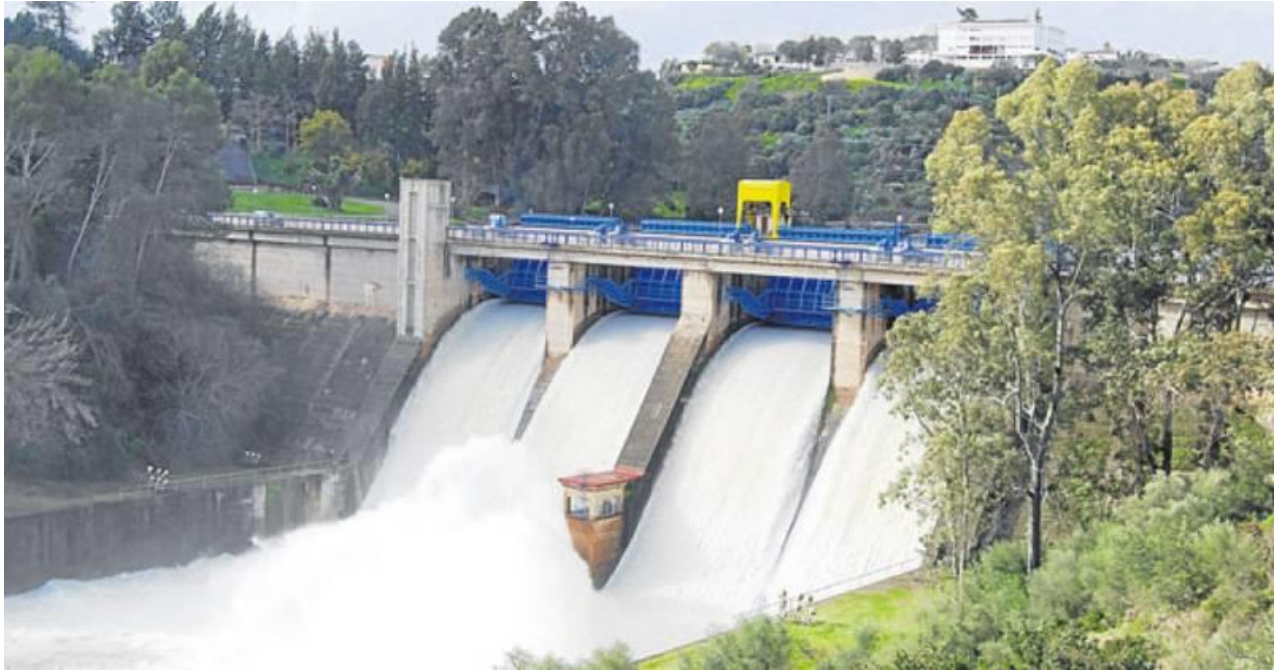
Ilustración 7 Presa de Derivación Bembézar (Córdoba, España), Fuente: (Exposito, 2013)
