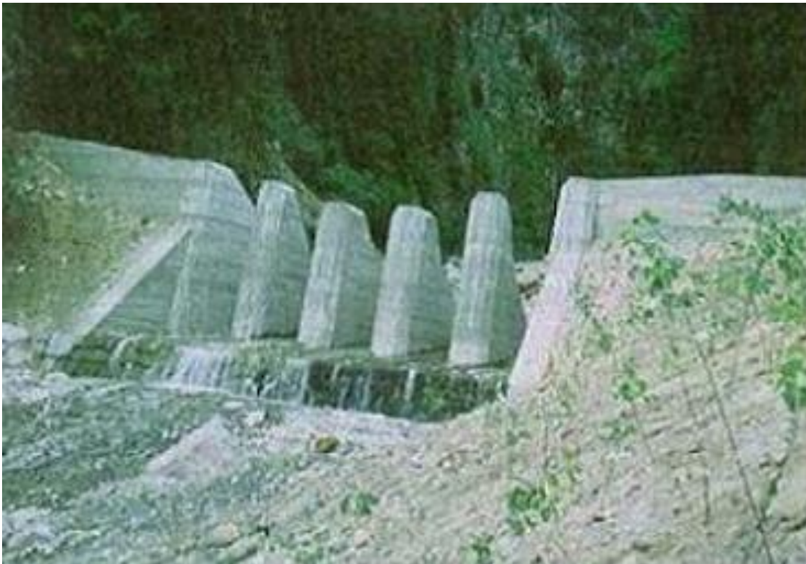
Ilustración 5 Presa Filtrante de Hormigón en un Torrente de los Alpes,
