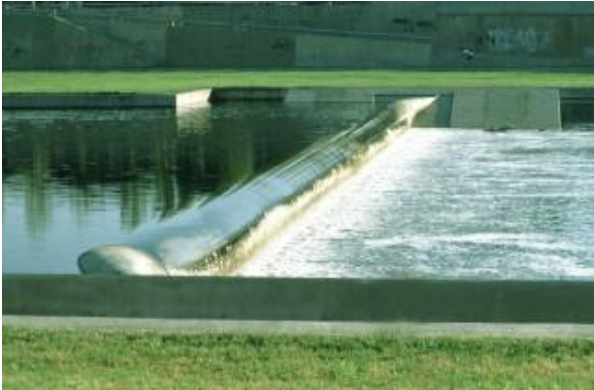
Ilustración 6 Presa de Control de Avenidas, Fuente: (Cordero, 2017)
