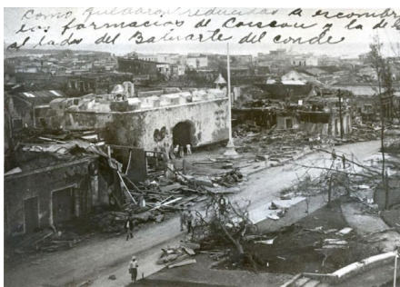
20 Estado en que quedó la Puerta del Conde y sus alrededores, luego del paso del ciclón San Zenón (1930).
