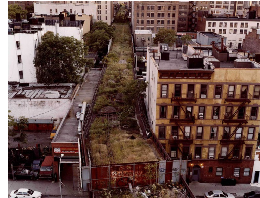
14 Línea férrea a finales del siglo XX.
