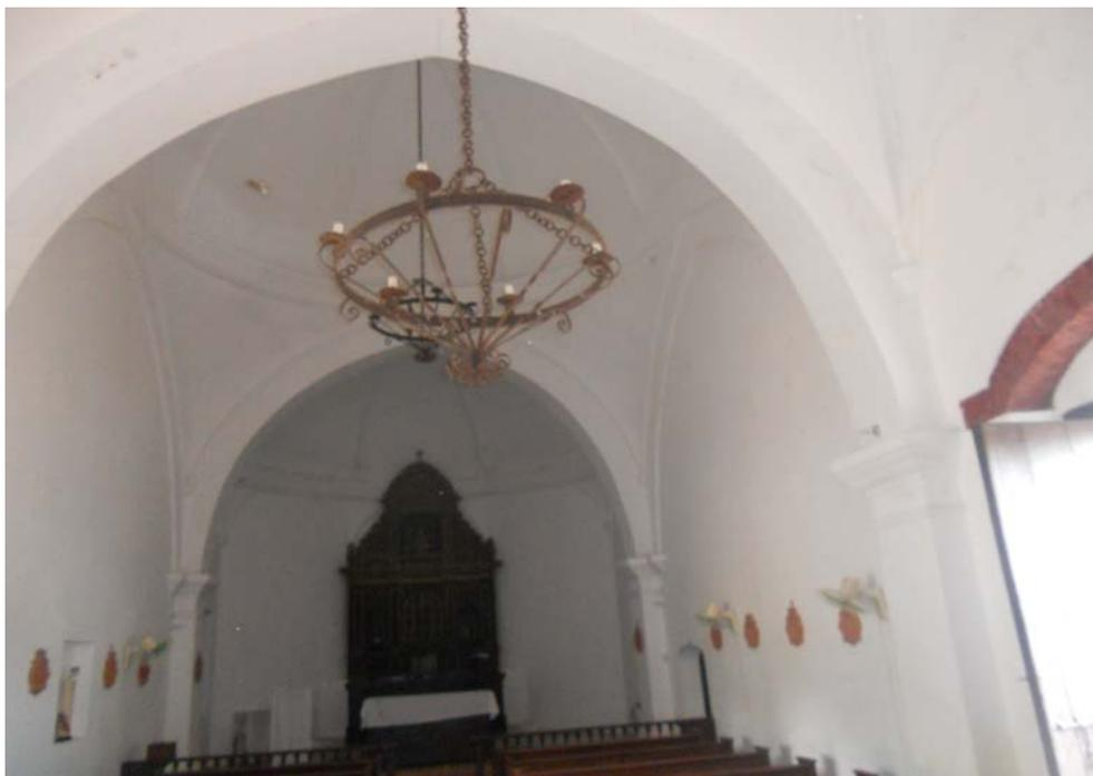
Ilustración 13. Interior de la Falsa Bóveda de Cañón del Santuario donde presenta desprendimiento del pañete que le fue reparado, la cual es sostenida por arcos punteados que descansan en los contrafuertes.
