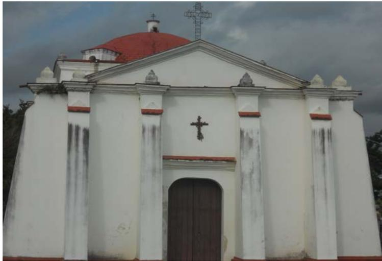
Ilustración 8. Contrafuertes del ábside vista Frontal del Santuario de Nuestra Señora de Aguas Santas en Boya, en la actualidad, donde se puede observar que se conforma de contrafuertes que sostienen la falsa bóveda de cañón, los cuales sufren un deterioro en su fachada estructural por la presencia de humedad ocasionada por las lluvias.
