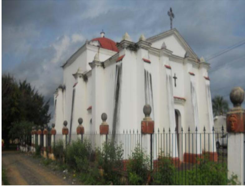
Ilustración 17. Vista Lateral Izquierda del Santuario en boya. En esta se visualiza el deterioro ocasionado por la aparición de vegetación en la techumbre de la iglesia, agrietando el revestimiento provocado por la humedad.
