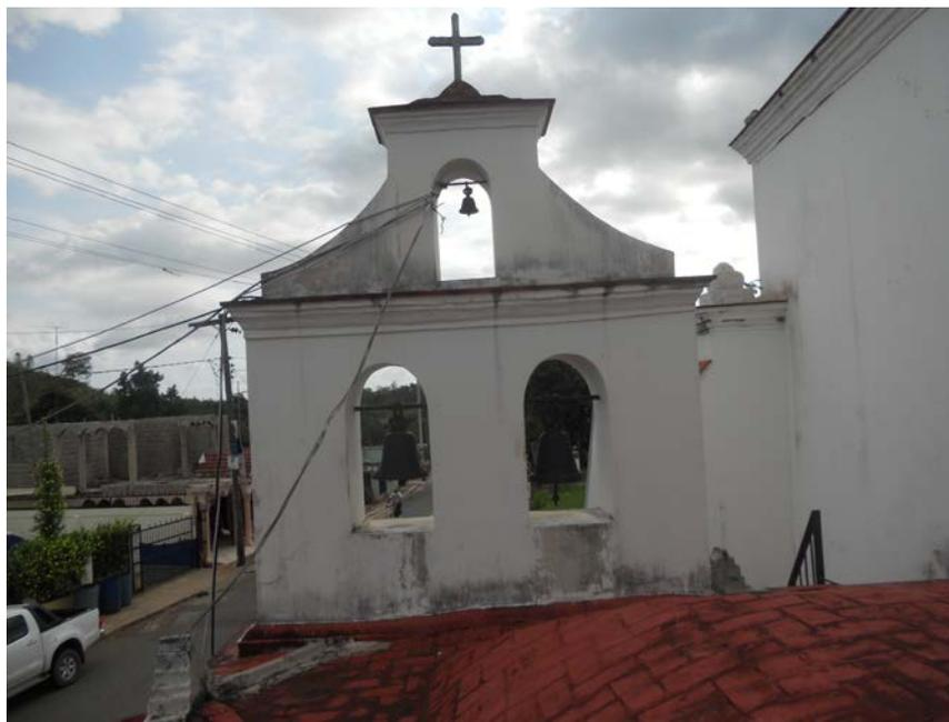
Ilustración 15. Vista trasera del santuario. Aquí se puede ver el campanario compuesto por tres campanas, dos inferiores de mayor tamaño y una en la parte superior más pequeña. Esta descansa en los muros que sostienen la cúpula vaída. Se evidencia el crecimiento de humedad en las paredes del santuario.
