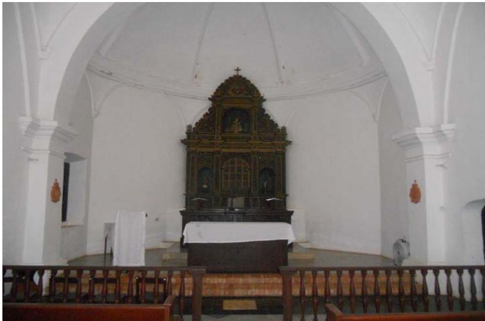
Ilustración 10. Arte interior de la cúpula central y la media cúpula del Santuario aguantada por los arcos y los muros de carga que trabajan recibiendo fuerzas de gravedad con su mismo peso.
