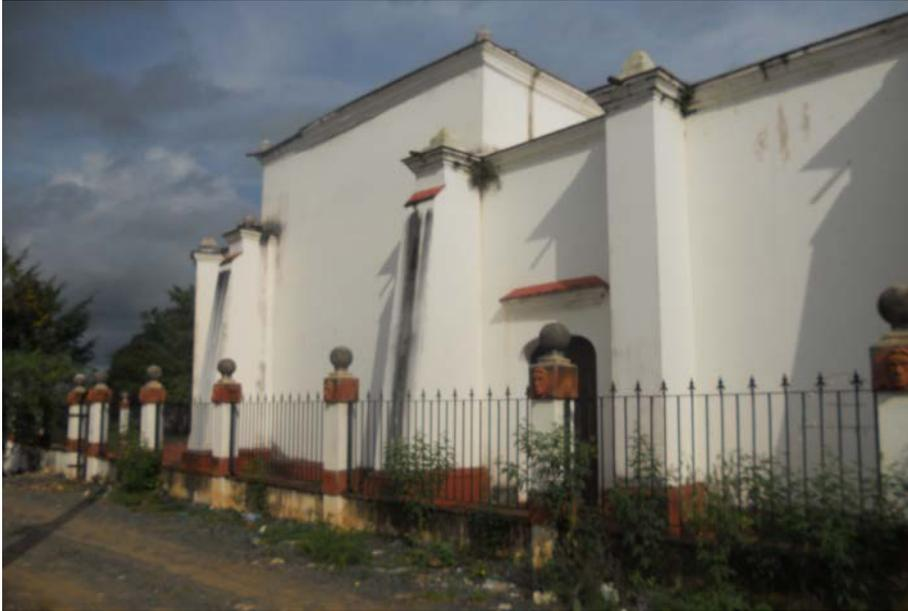
Ilustración 16. Vista lateral derecho del santuario donde también se presenta fisuras provocado por el nacimiento de la vegetación, debido a la humedad.
