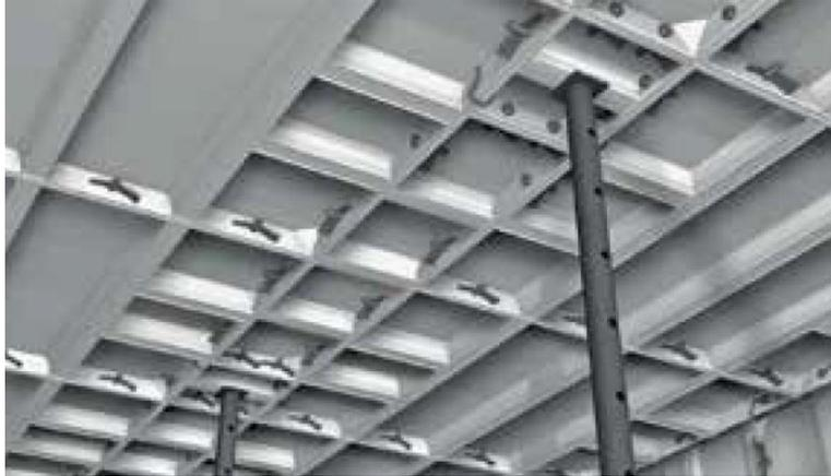
*Ilustración 23. Puntal de losa (FORSA, 2015)*
