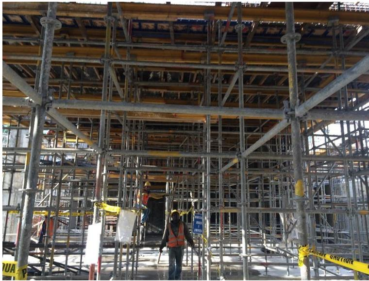
*Ilustración 31. Andamio multidireccional (FORSA, 2015)*
