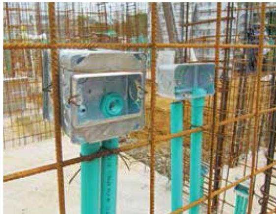
*Ilustración 12. Caja Eléctrica. (FORSA, 2015)*
