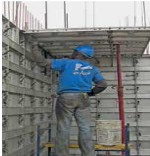
*Ilustración 21. Encofrado de losa. (FORSA, 2015)*
