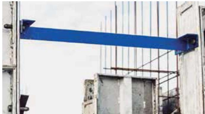
*Ilustración 17. Tensor de ventanas. (FORSA, 2015)*
