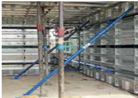
*Ilustración 19. Tensor de muro (FORSA, 2015)*
