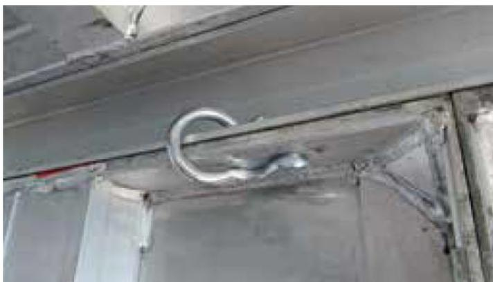
*Ilustración 22. Pin grapa. (FORSA, 2015)*
