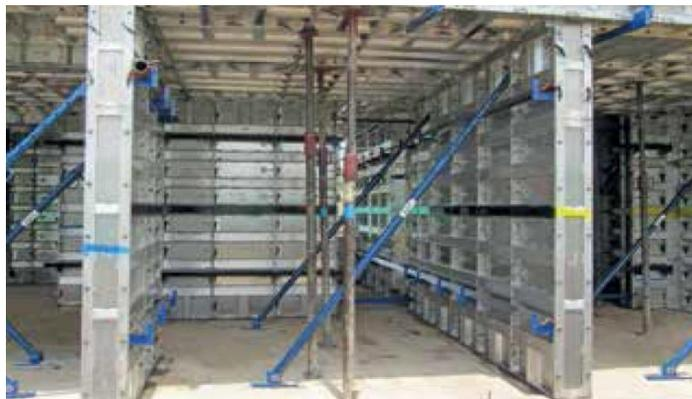
*Ilustración 24. Tensor de muro (FORSA, 2015)*
