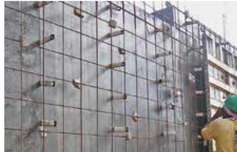
*Ilustración 14. Corbatas. (FORSA, 2015)*
