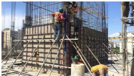
Ilustración 6. Tensores de muro. (FORSA, 2015)
