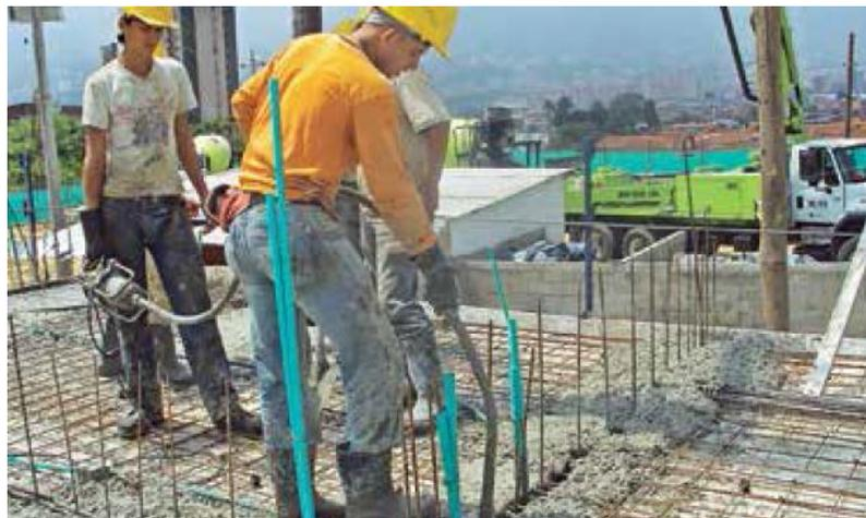
*Ilustración 25. Vaciado de Hormigón (FORSA, 2015)*
