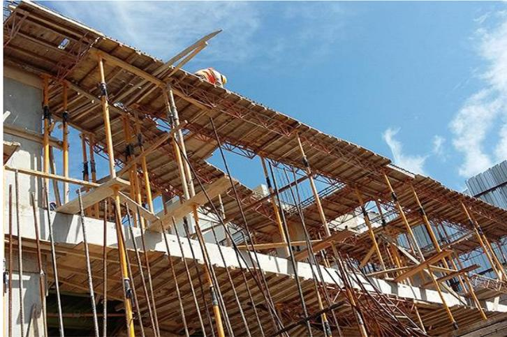
*Ilustración 2. Encofrado de madera (FORSA, 2015)*
