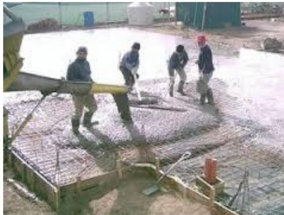
*Ilustración 8. Vaciado de Hormigón. (Google)*
