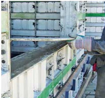
*Ilustración 15. Tapa muros. (FORSA, 2015)*
