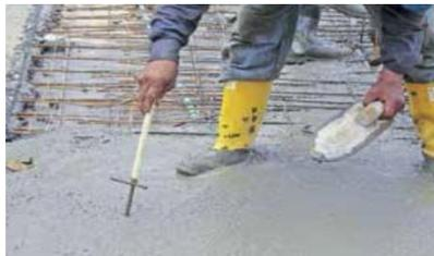
*Ilustración 27. Niveles de vaciado (FORSA, 2015)*
