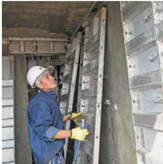
*Ilustración 30. Desencofre de muro (FORSA, 2015)*
