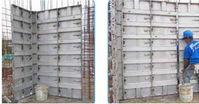
*Ilustración 13. Láminas de muro. (FORSA, 2015)*
