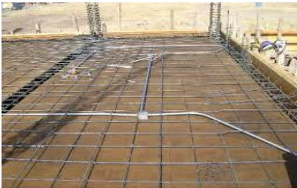
*Ilustración 7. Tuberías en losa (Google)*
