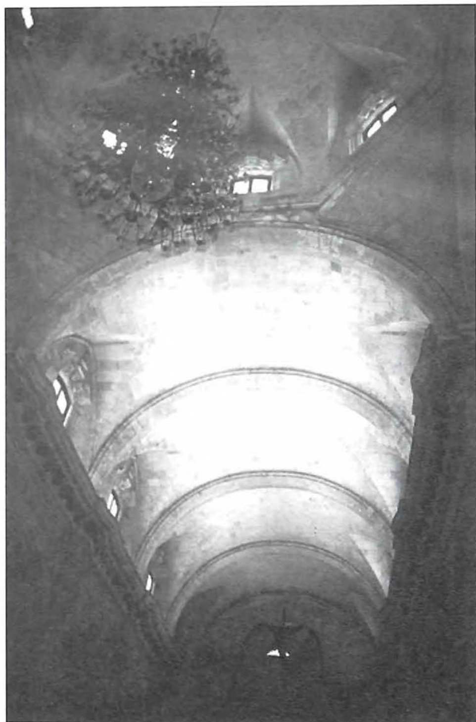
Techo de la nave central, donde se observa la lámpara que cuelga desde la cúpula del crucero de la catedral.
