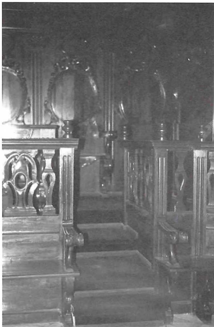
Detalle de la restauración del coro de los canónigos.
