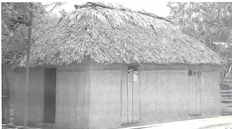
FIGURA 15. Bohío de palos parados con techo de cana a cuatro aguas, en Las Charcas, Azua. Fuente: EPV. 2008.
