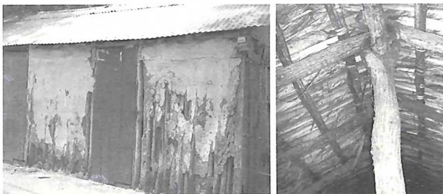
FIGURA 2. Pared de palos parados con restos de embarrado y pie de amigo soportando la cumbrera de un bohío. Foto: EPV.
