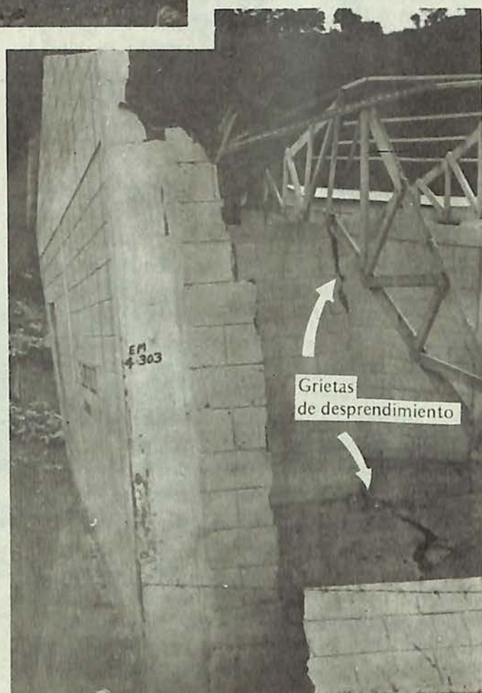
Fig. 23. Fachada lateral Oeste.
