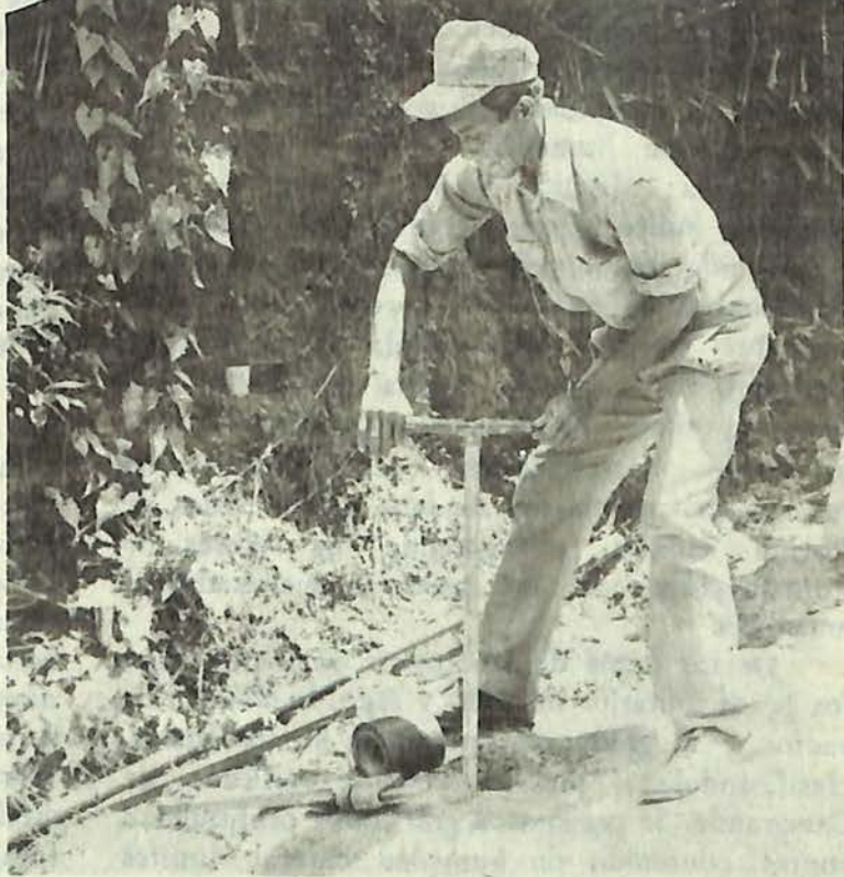
Fig. 3. Limpieza del barreno con la cuchara de postear, Palo Quemado.
