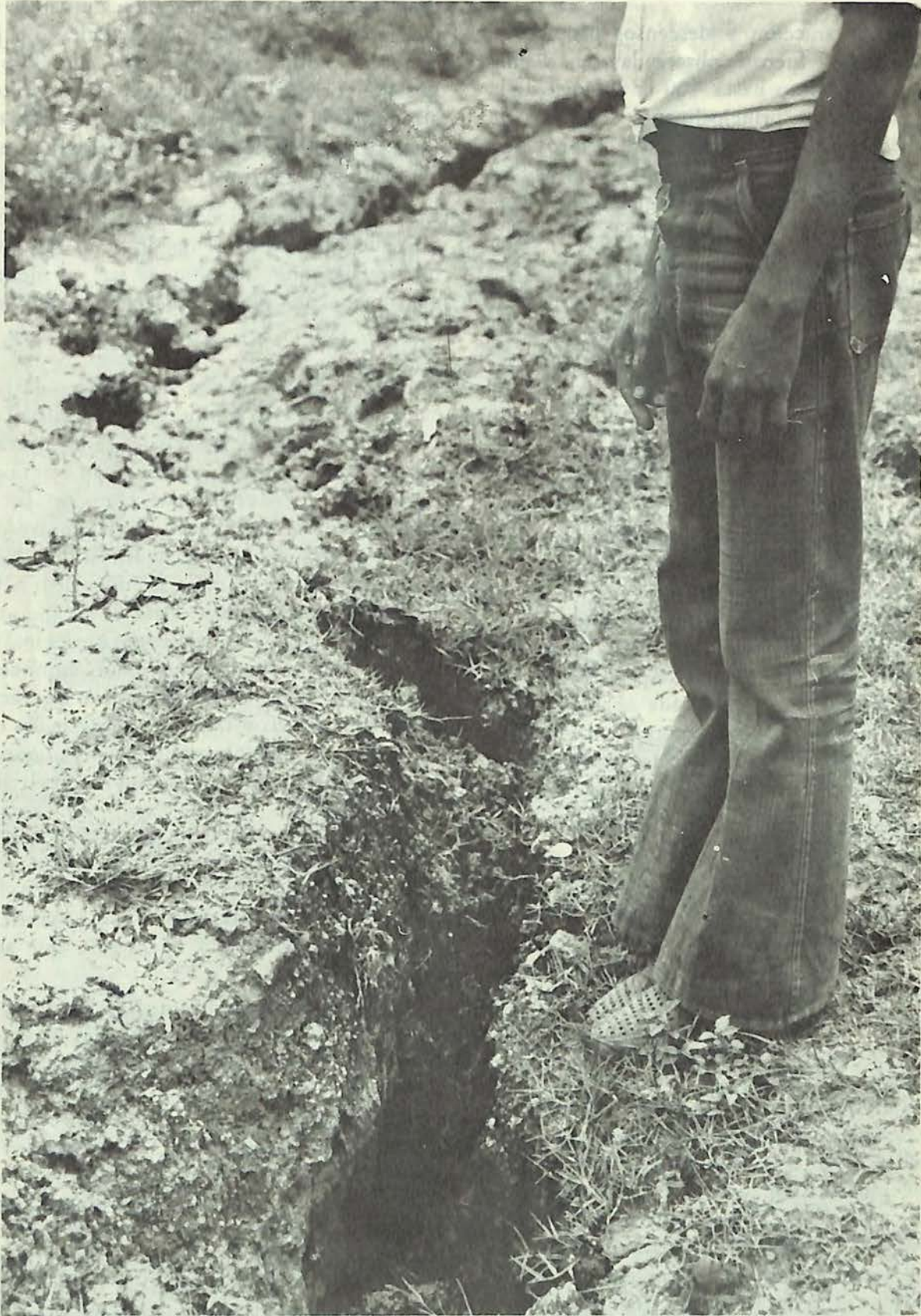
Fig. 5. Grietas en el callejón de la Hoya.
