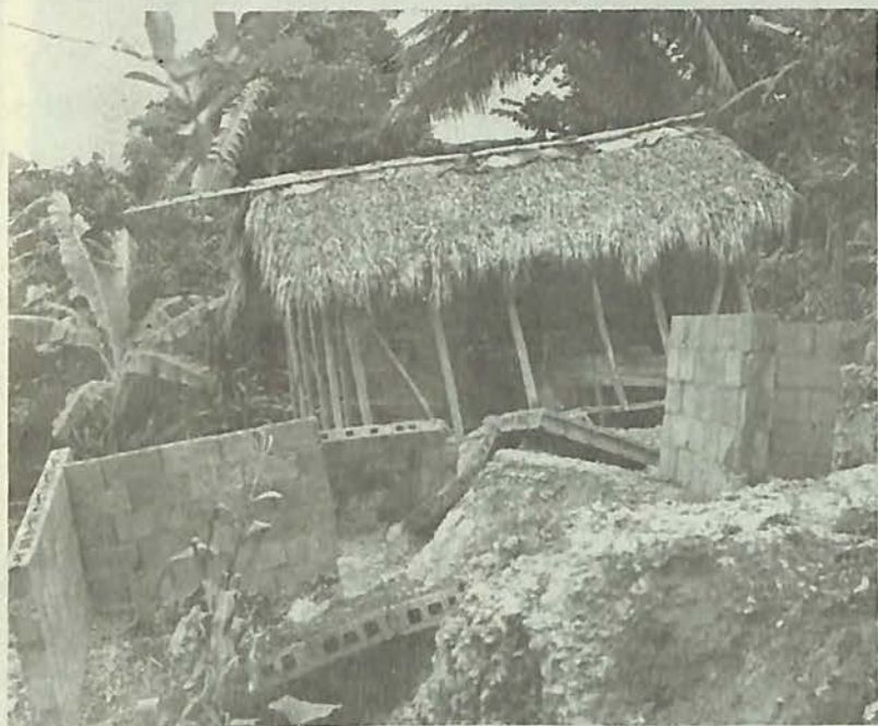
Fig. 26 Después de la remoción de la porción de madera de las paredes y el techo.
