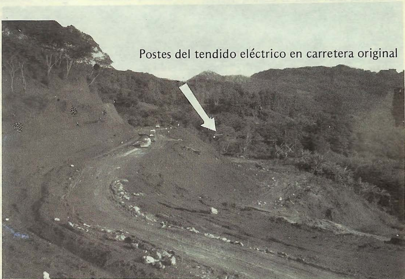
Fig. 42. Fallas en la carretera Luperón, 1970.
