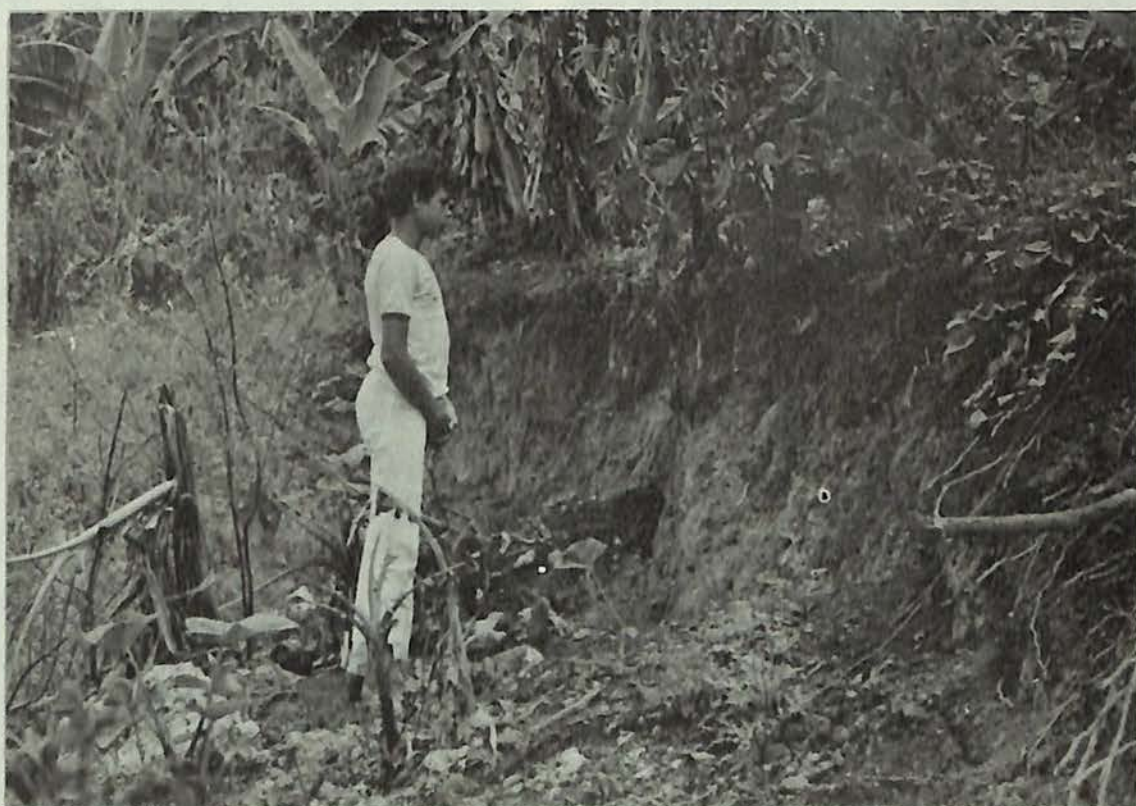
Fig. 15 Grieta de tracción y descenso próximo a la laguna. Palma Picada.
