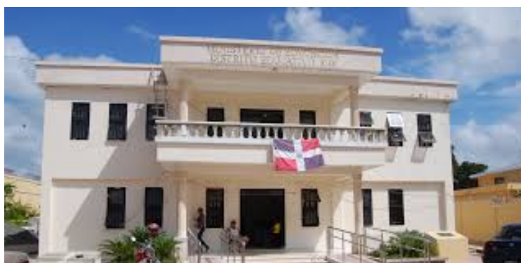
Figura 26. Fuente: Ministerio de Educación. Fachada principal del Distrito Educativo 10-01.
