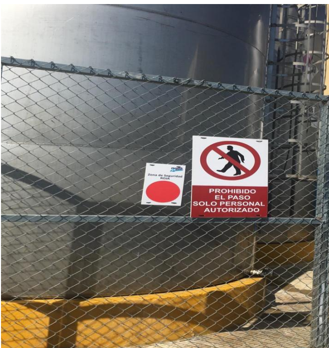
Área de almacenamiento
