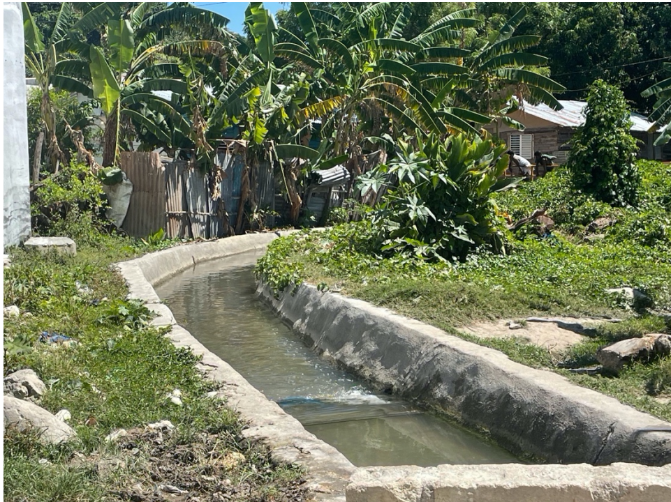
Figura 31: Rigola ubicada entre las viviendas de la comunidad, próximo a Las Ruinas de Pueblo Viejo.
