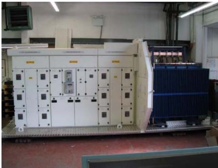
Figura 4.9: estructura interna de la subestación submarina
