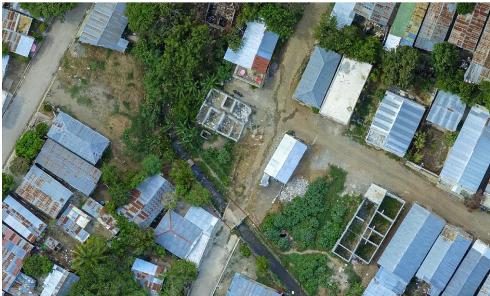
Cañada contaminada con disposición final al Río San Juan Fuente: (Propia, 2021)
