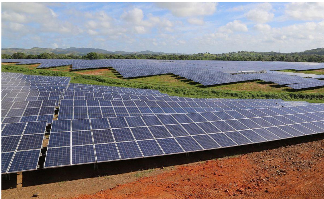
Figura 12: RD cuenta con dos parques solares fotovoltaicos, ubicados en las provincias Monte plata y Montecristi.
