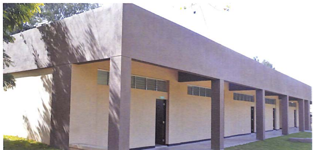
Nuevo edificio de Aulas
