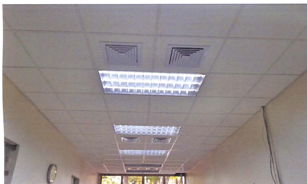
Remodelación de plafones y ventanas, Facultad de Arquitectura
