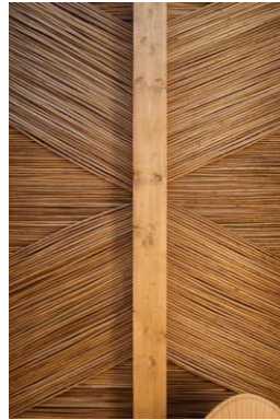
Varillas de ratán, con vigas de madera.
