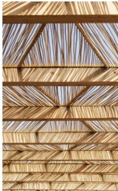
Trenzado de caña, con vigas de madera.
