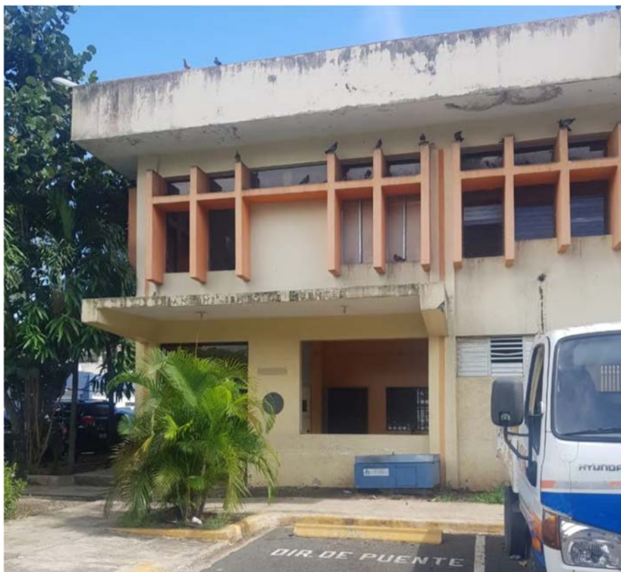
Figura 2. Fachada principal del edificio de Pavimentación Asfáltica del MOPC (Elaboración propia).
