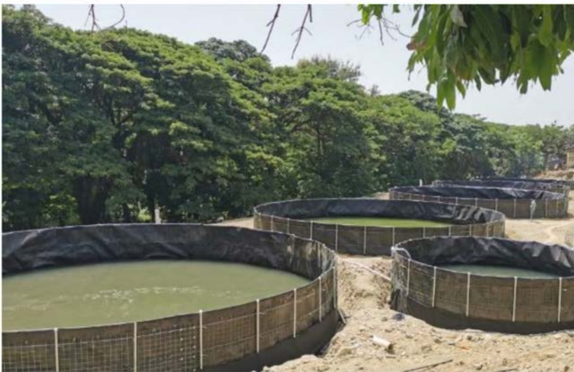
Figura 22. Estanques en geomembrana
