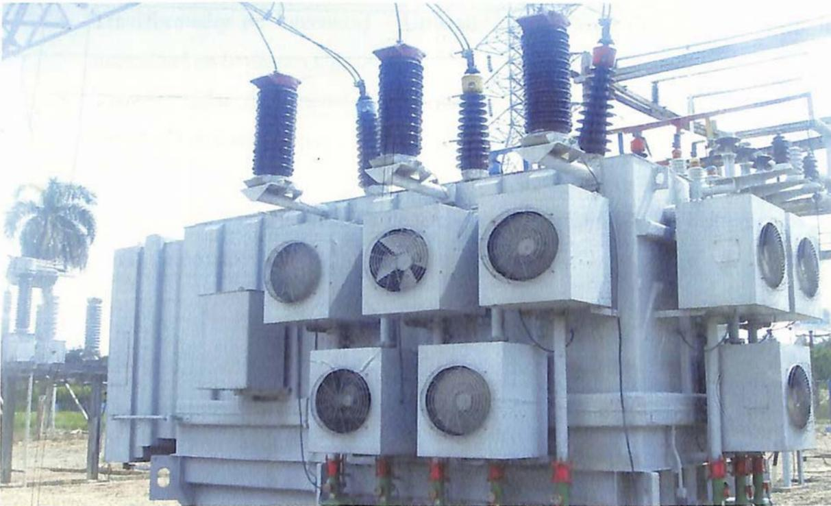
Figura 4.9, Transformadores Potencia.
