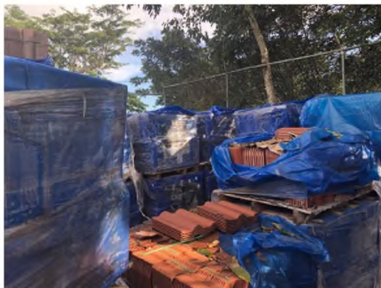
Fig. 30 Almacenamiento de tejas
