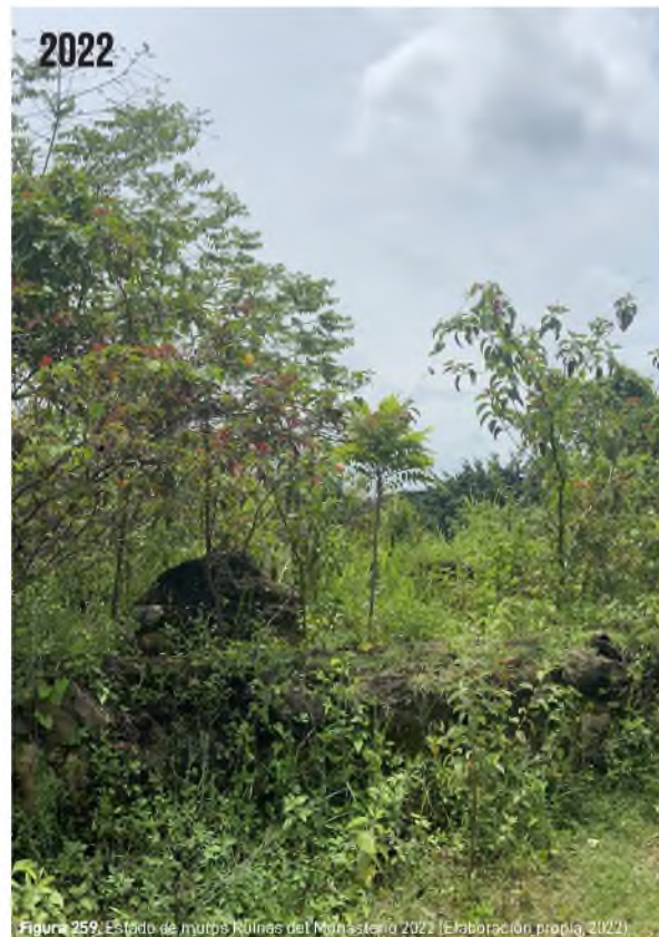
Figura 259. Estado de muros Ruinas del Monasterio 2022 (Elaboración propia 2022).
