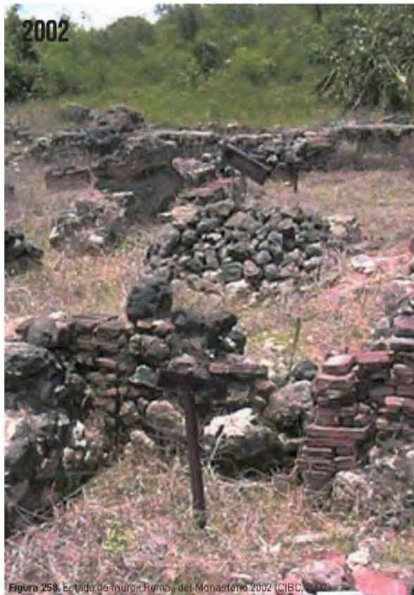
Figura 258. Estado de muros Ruinas del Monasterio 2002 (CIBC, 2022).
