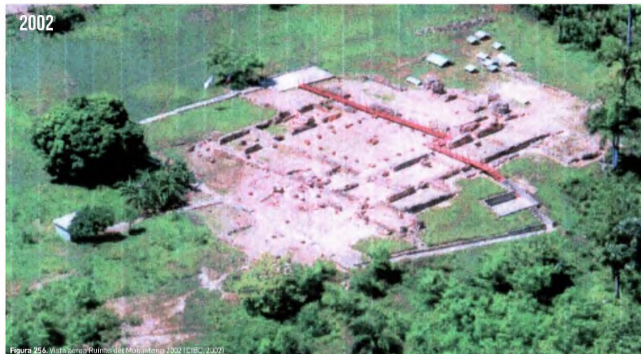
Figura 256. Vista aérea Ruinas del Monasterio 2002 (CIBC, 2002)
