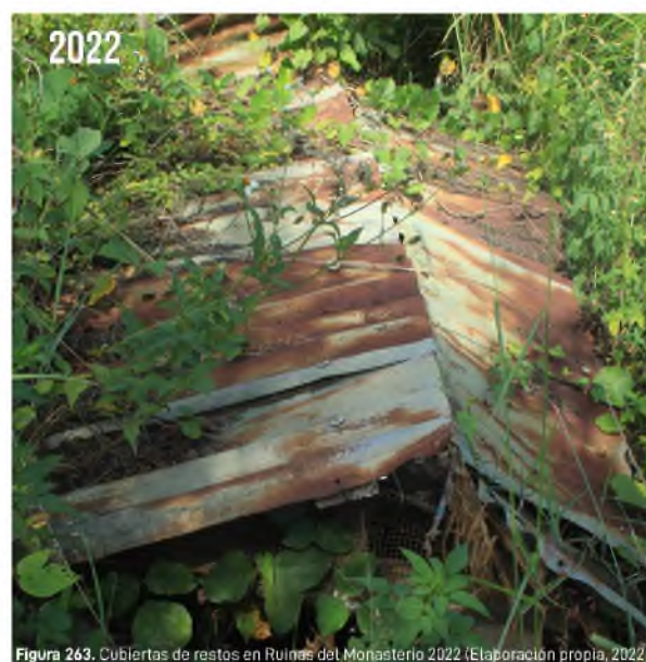
Figura 263. Cubiertas de restos en Ruinas del Monasterio 2022 (Elaboración propia, 2022)
