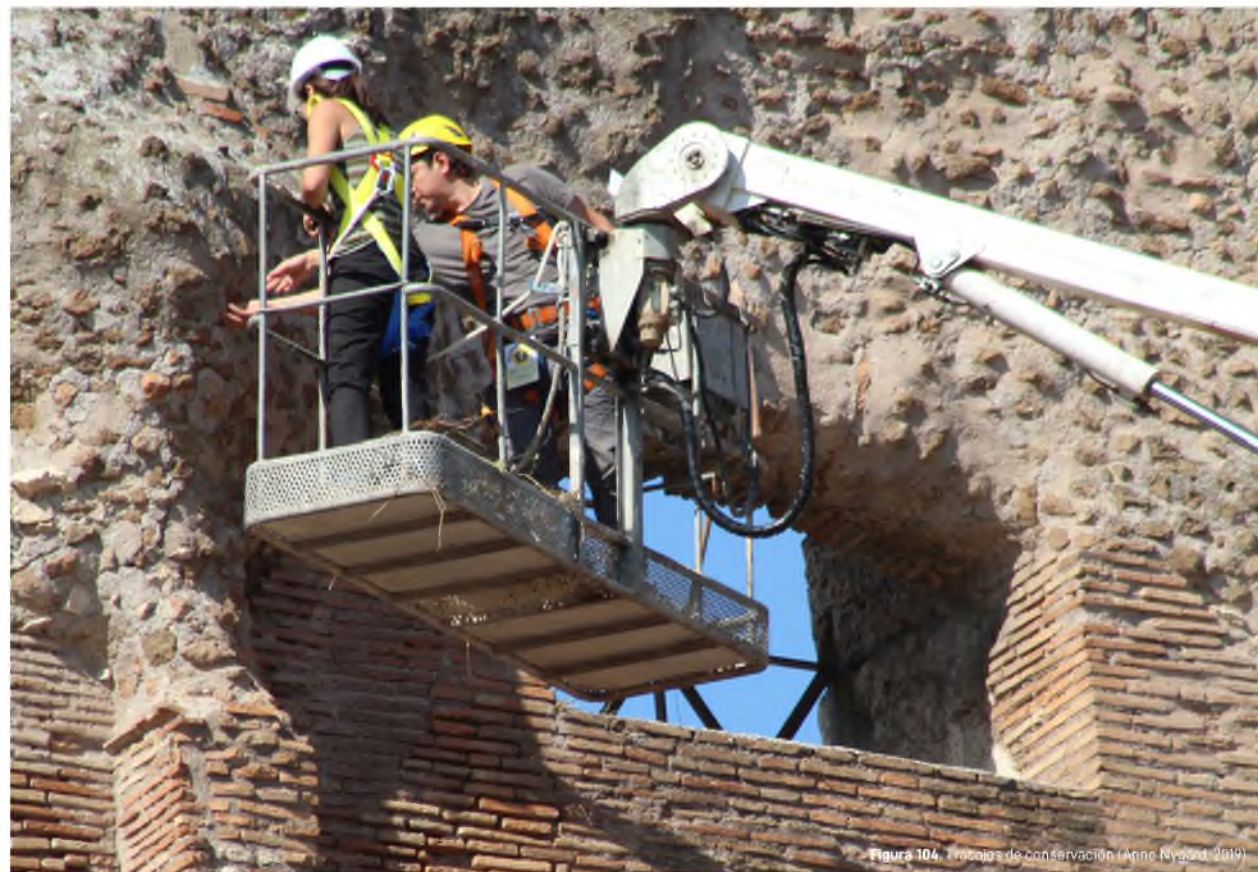
Figura 104. Trabajos de conservación (Anne Nygard, 2019)
