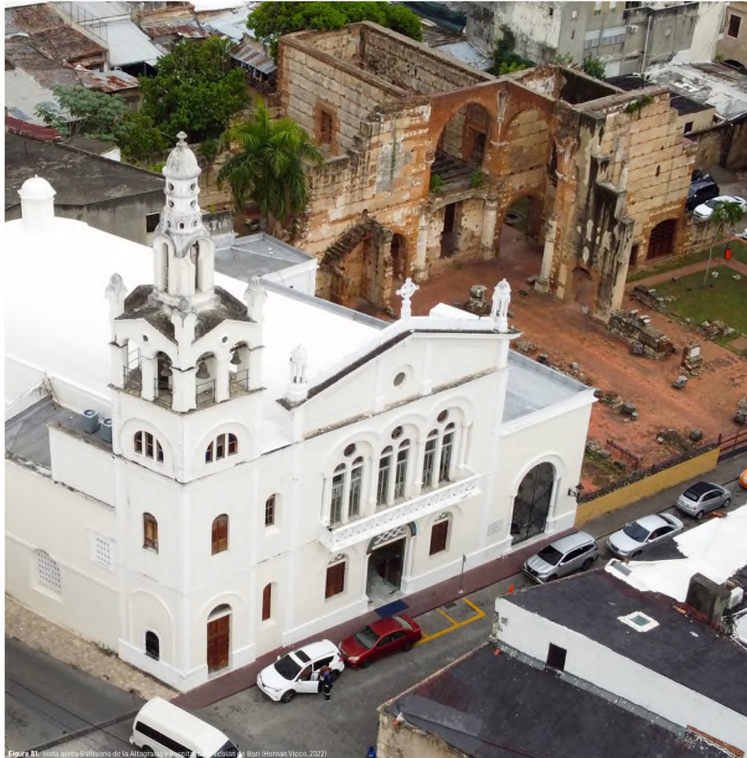
Figura 81. Vista aérea del Santuario de la Altarelli y Hospital de Nicolás de Bari (Hernán Vicco, 2022)
