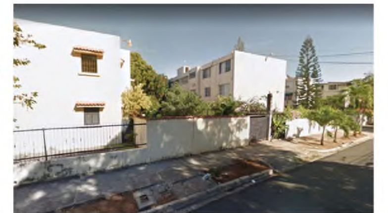
Calle Hermanos deligne (frente al contenedor)
