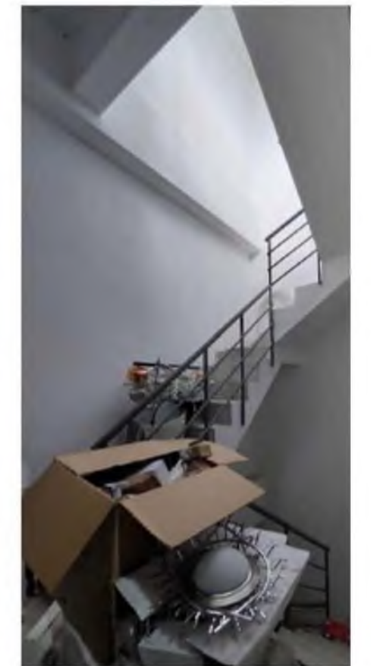
Escalera de Emergencia
