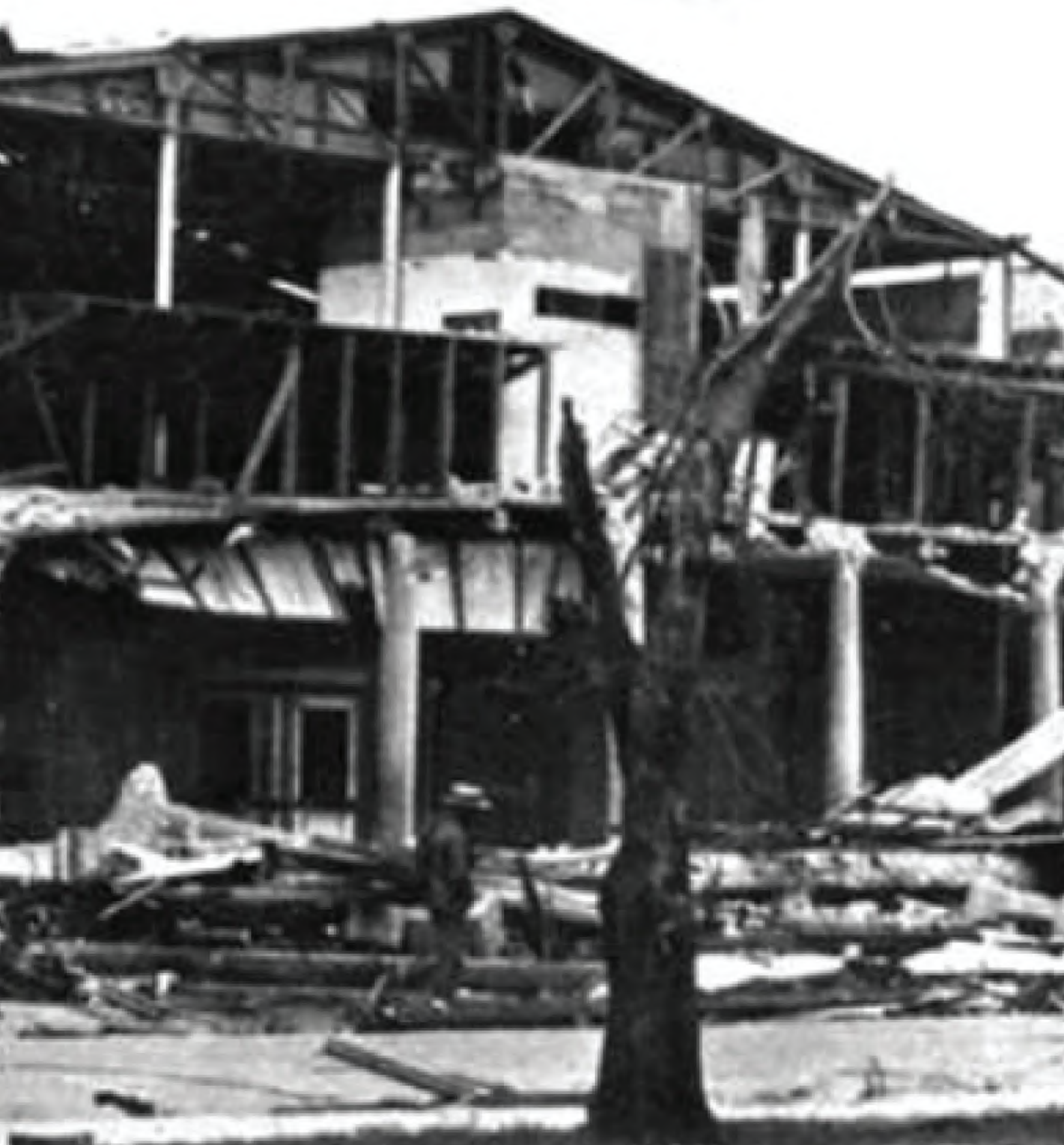
29. Imagen: Teatro Independencia destruido. Fuente: Las Salas de Cine en la República Dominicana .
