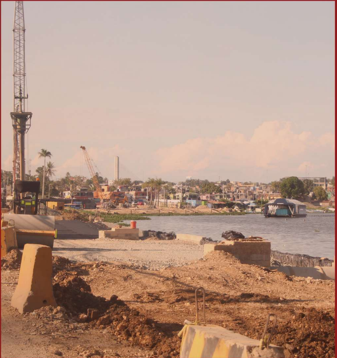
115. Imagen: Vistas del lugar de implantación. Fuente: Elaboración propia.
