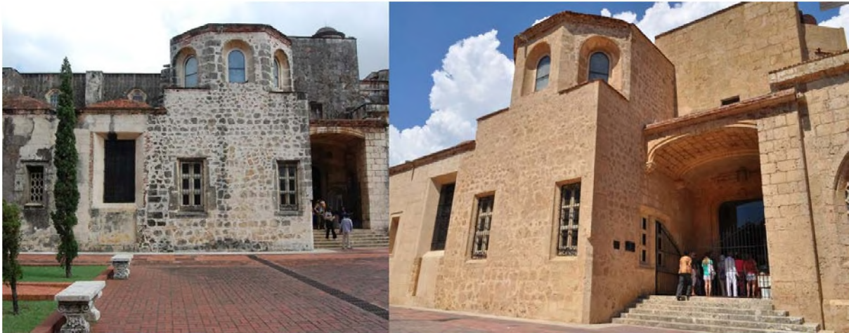
Figura 9: Antes y después del proyecto de restauración.
