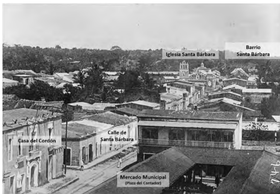
Figura 3. Vista del acceso al barrio de Santa de Bárbara.
