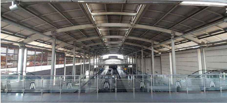
Ilustración 59– Interior de la estación Máximo Gómez.
