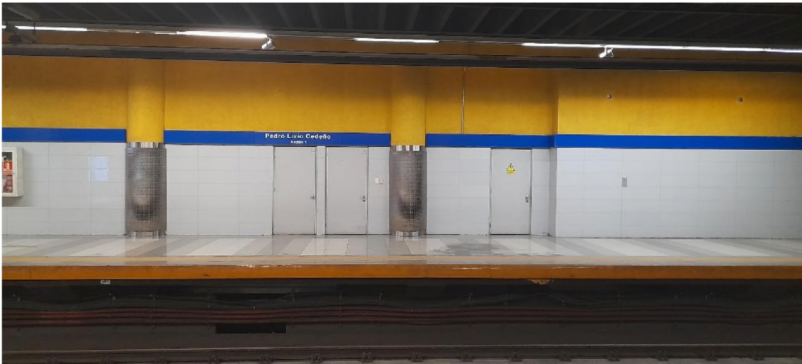
Ilustración 95– Pasillo estación Pedro Livio Cedeño parte 3.
