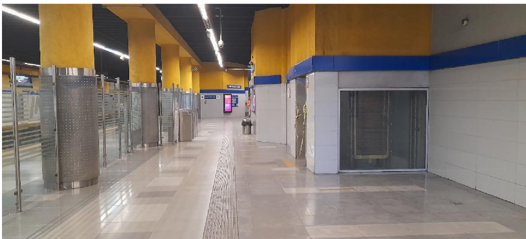
Ilustración 93– Pasillo estación Pedro Livio Cedeño.
