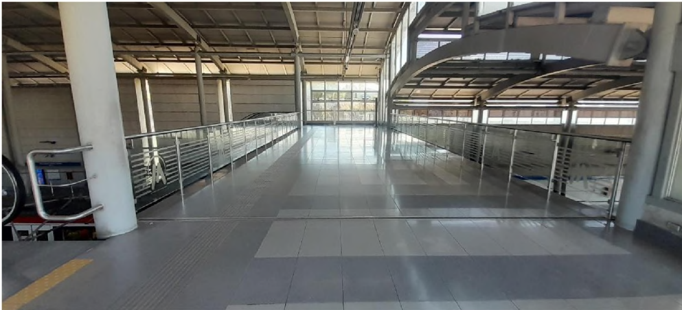
Ilustración 88– Entrada de la estación Máximo Gómez.
