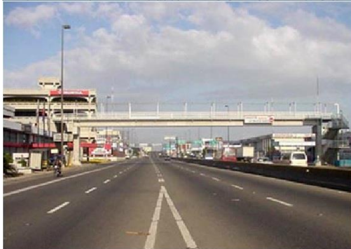
Ilustración 14. Puente peatonal tipo viga Ferretería Haché, Av. John F. Kennedy.
