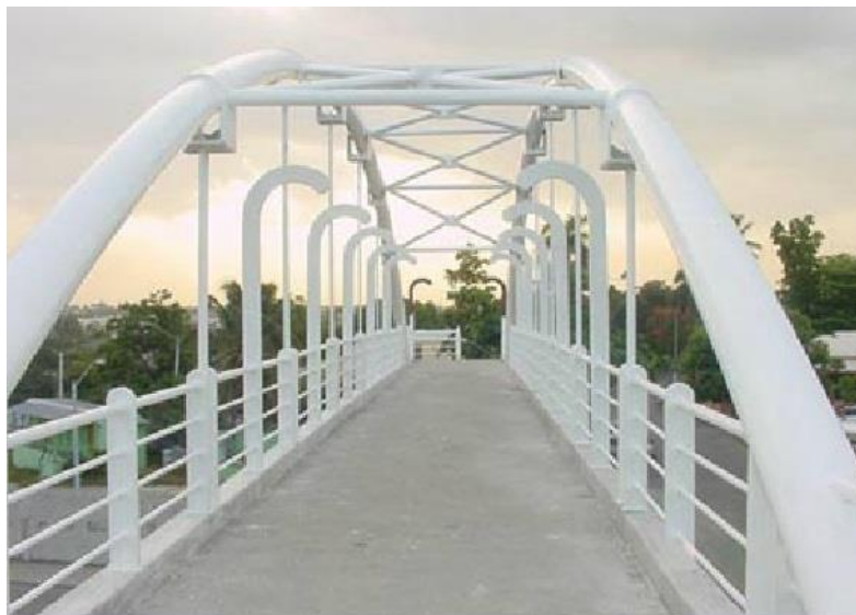
Ilustración 15. Puente peatonal en forma de arco, Av. Los Próceres.
