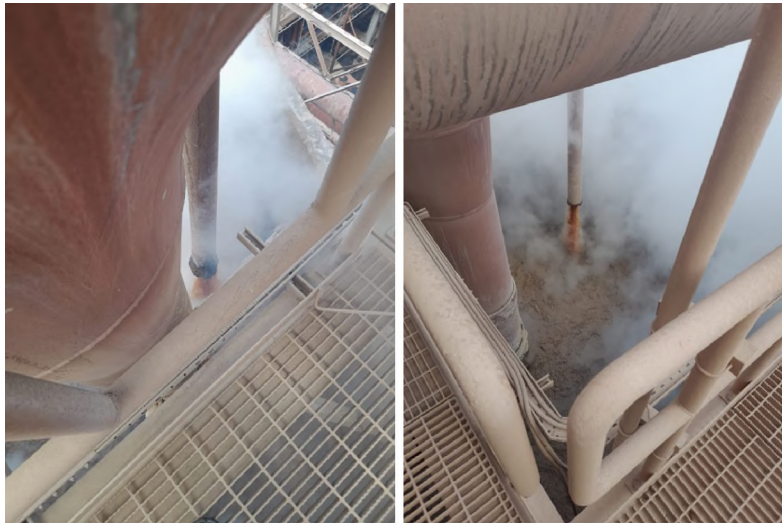
Figura 13. Adición de solución ácida de cobre proveniente de los CCDs en los tanques.
