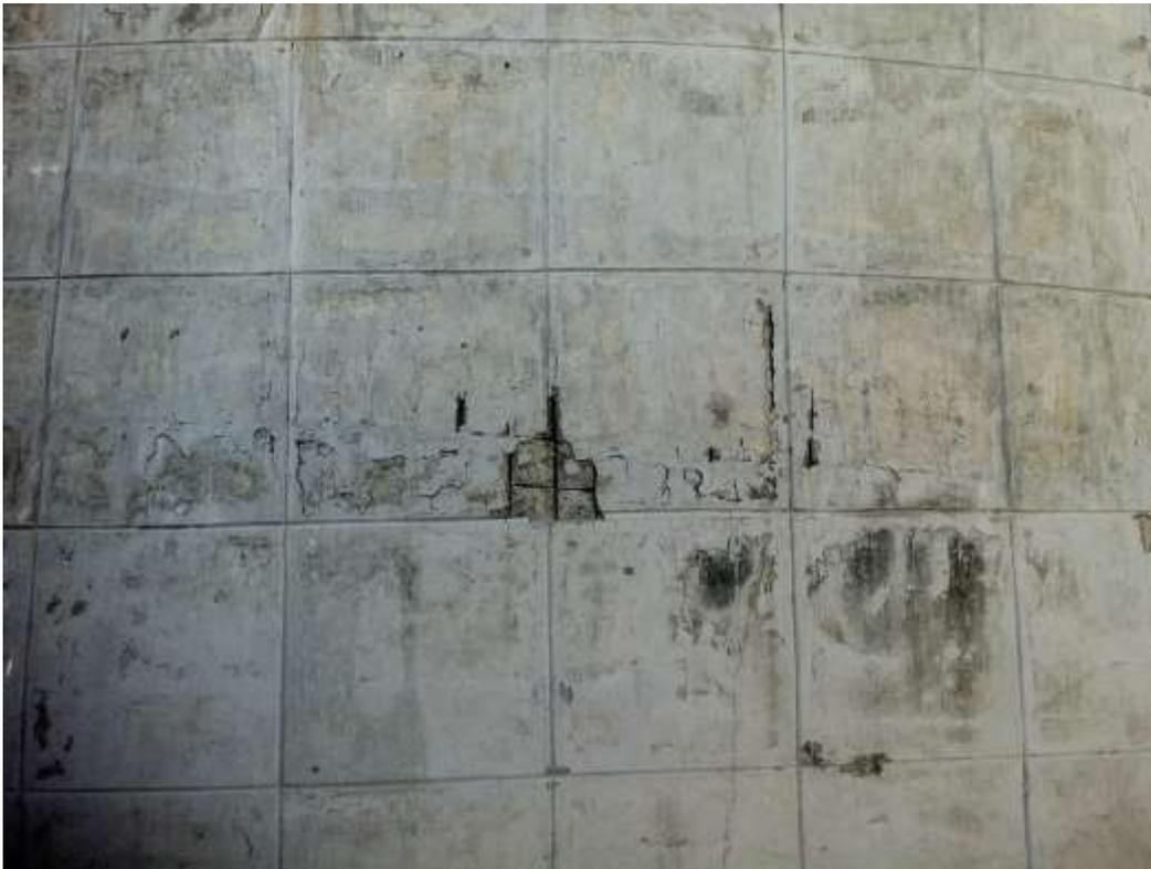
Ilustración 27. Descascaramiento del hormigón en la Autopista las Américas.
