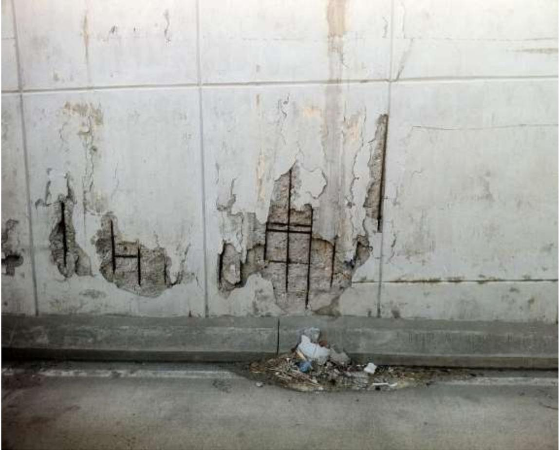
Ilustración 28. Descascaramiento del hormigón por la corrosión del acero.
