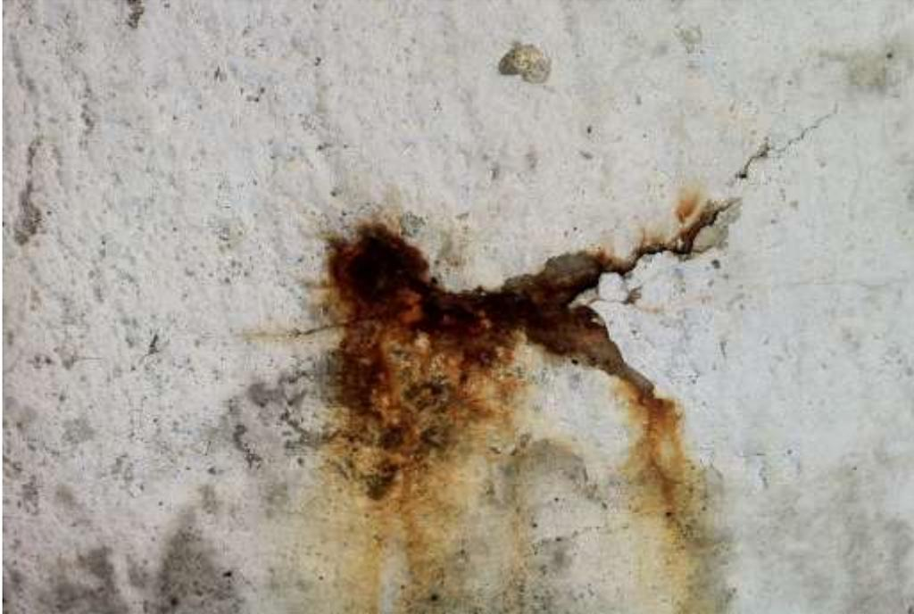
Ilustración 26. Corrosión de la armadura.
