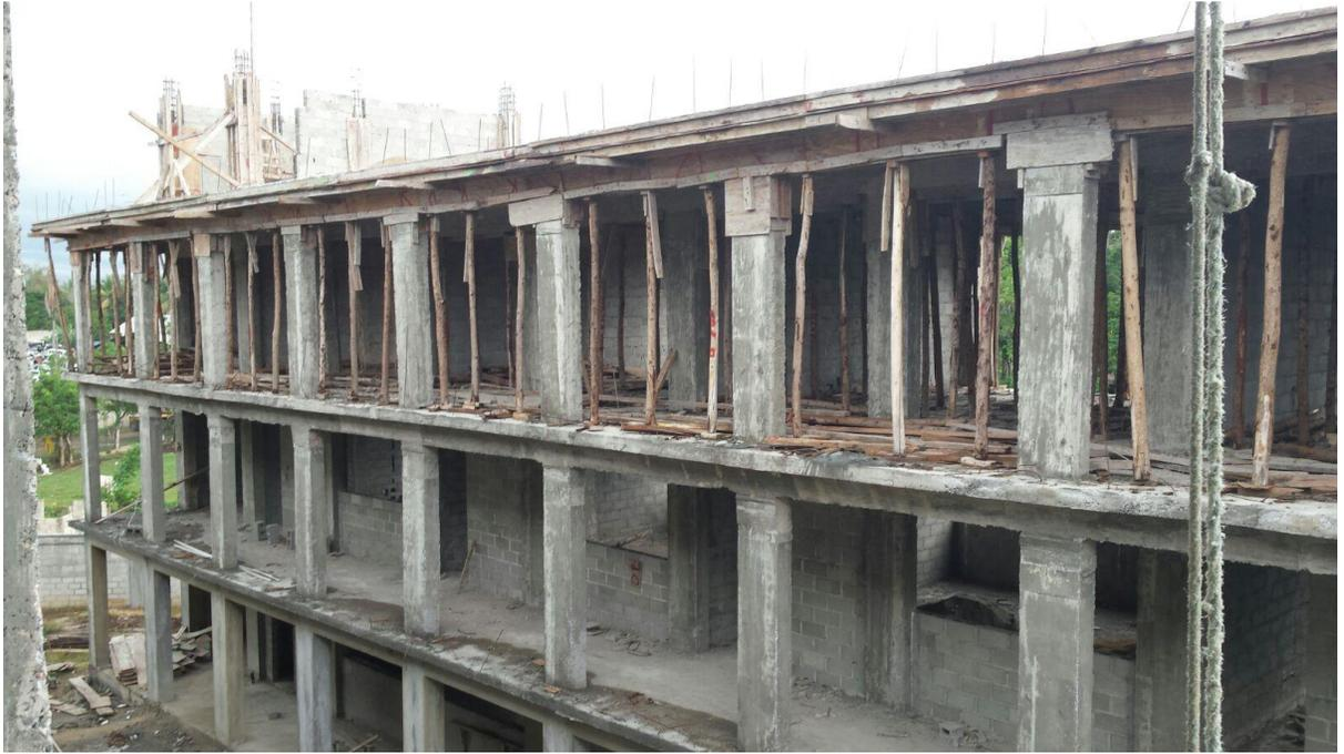
*Ilustración 37: "Construcción de escuela con sistema aportado en hormigón armado"*
