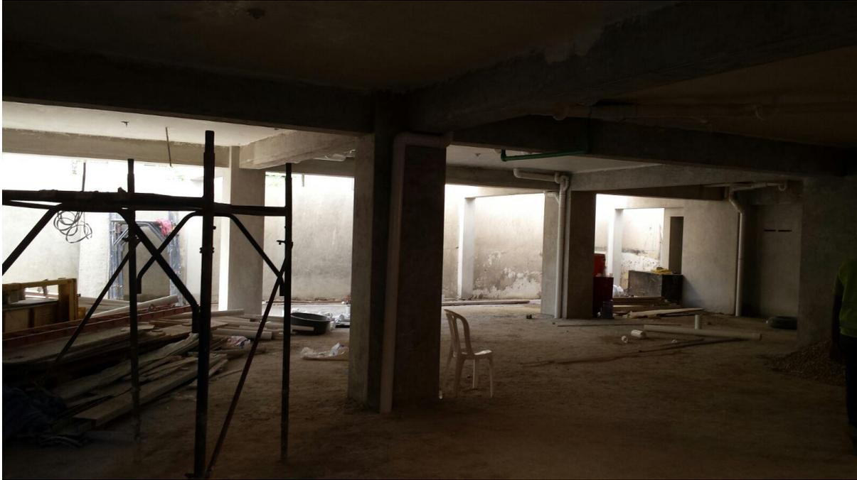
*Ilustración 33: "Sistema aporticado en hormigón armado"*
