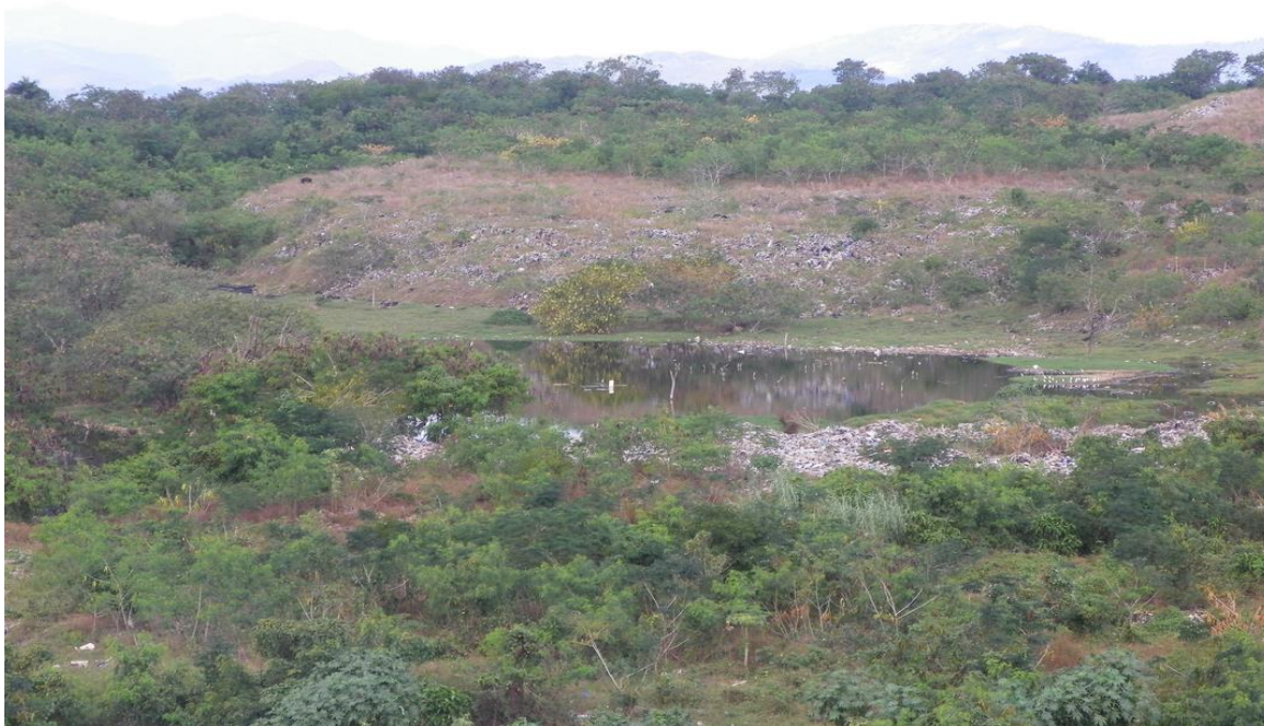
Figura 8.6 Lagunas en donde son almacenados los lixiviados generados en el vertedero de Duquesa
