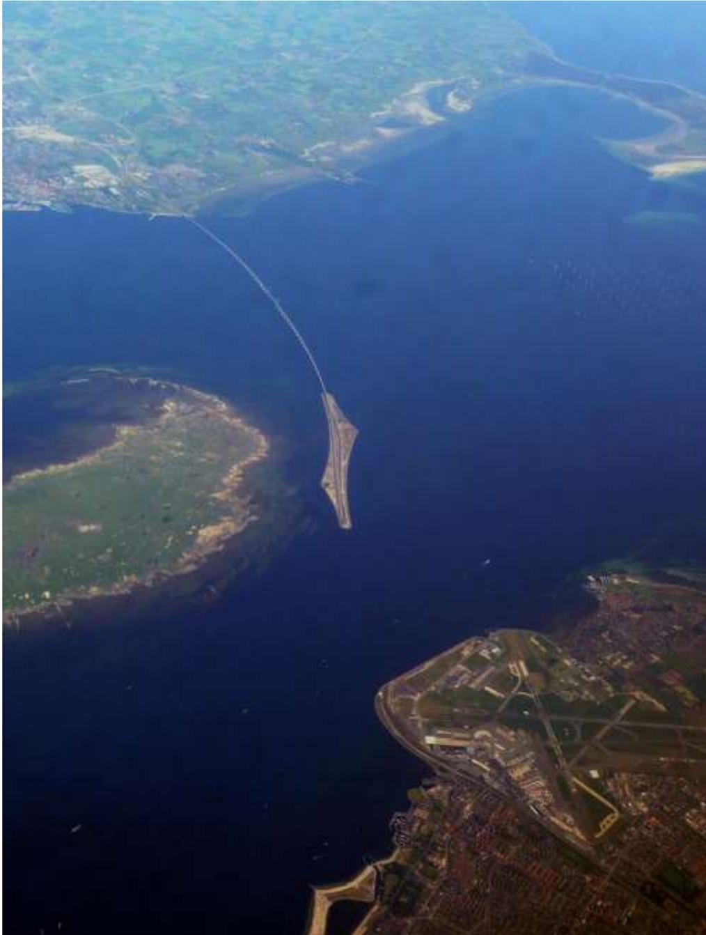
**Ilustración 8.** El puente de Oresund conecta Dinamarca y Suecia a través del estrecho de Oresund. Esta auténtica obra de arte, que enlaza Copenhague y Malmö en un total de 16km de carretera, comienza siendo un puente, y para no cerrar por completo el estrecho, se transforma en un túnel subacuático, permitiendo así el paso de barcos por el canal.
