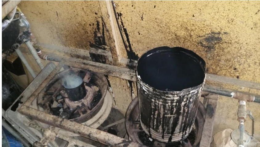
Ilustración 23: Calentamiento del AC-30 con polímero para los agregados. Fuente: Laboratorio P & R Ingeniería.
