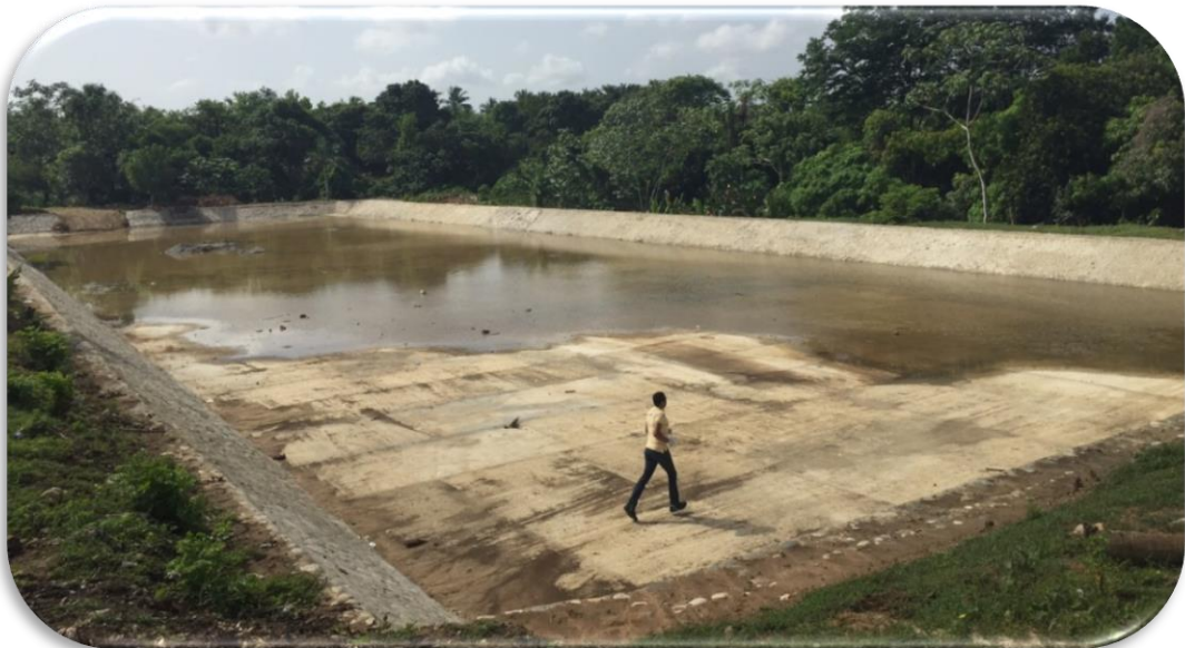
Ilustración 4. Foto de la Laguna facultativa Fuente: Propia
