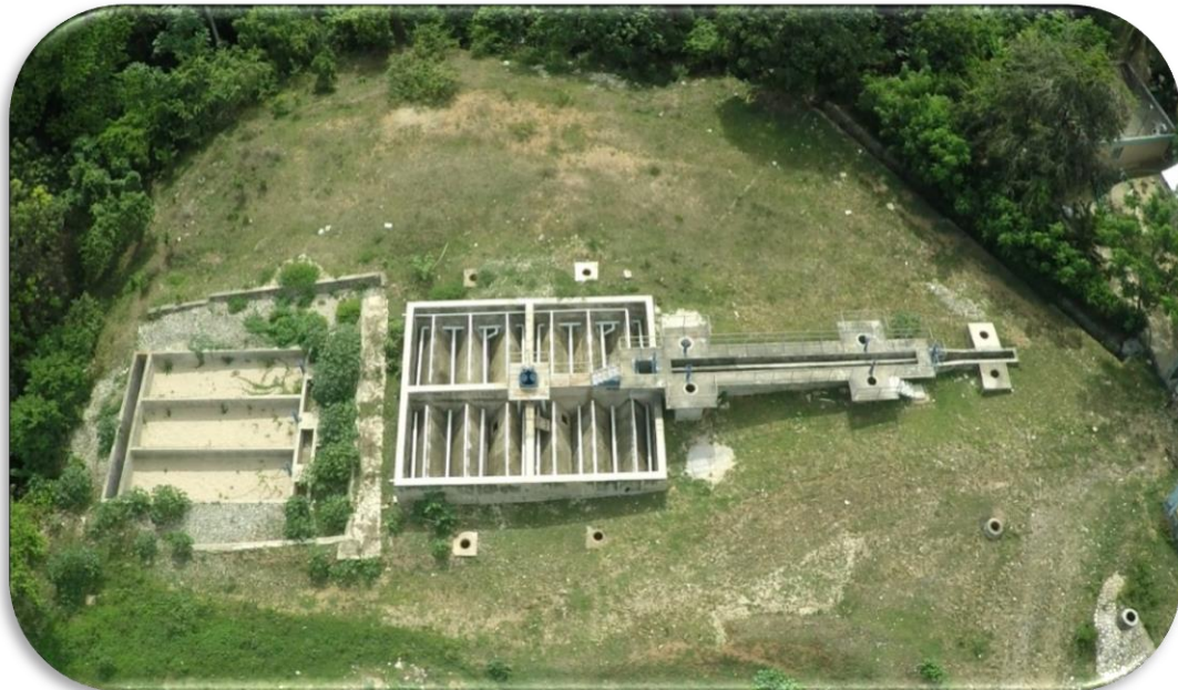
Ilustración 3. Vista aérea de la planta de tratamiento de aguas residuales Fuente: Propia
