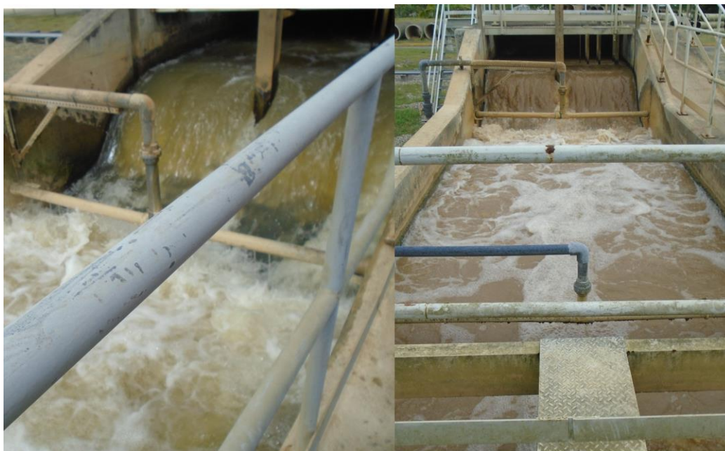
Ilustración 20. Mezclador tipo vertedero rectangular con rampa operando correctamente.
