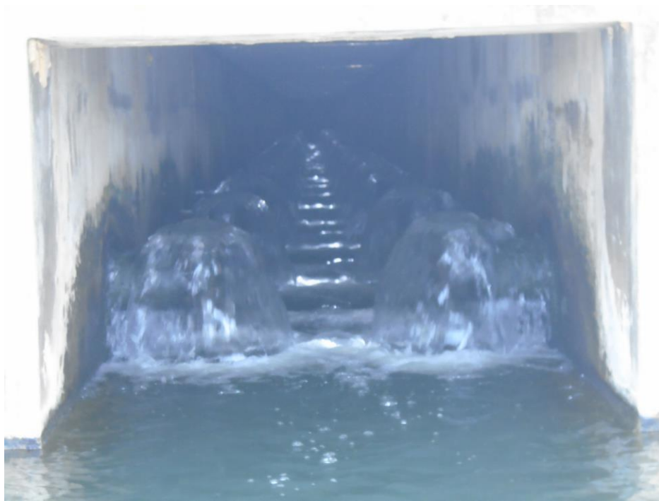
Ilustración 16. Salida del agua de los sedimentadores
