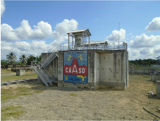
Caja de entrega de agua cruda.
