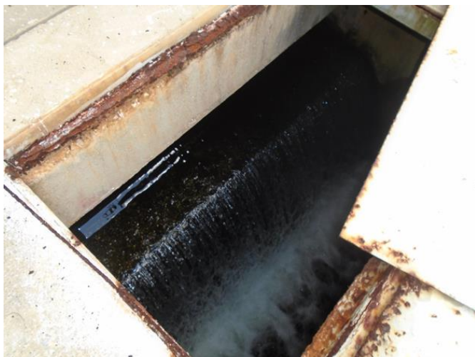
Canal de salida de agua filtrada.
