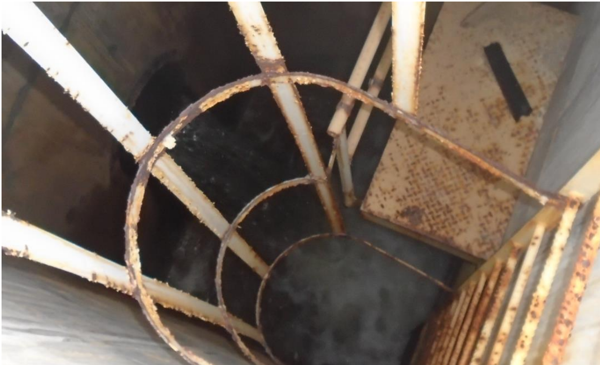
Ilustración 19. Muestra de pozo donde descarga tubería de drenaje de filtros.
