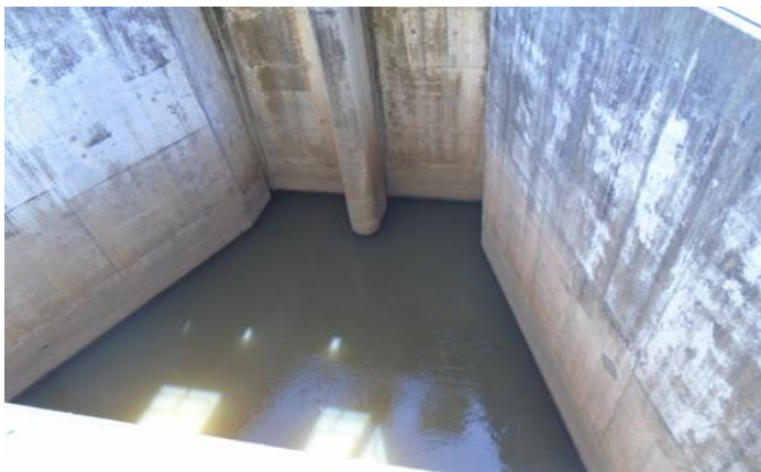
Entrada del agua a la obra de toma de agua cruda.
