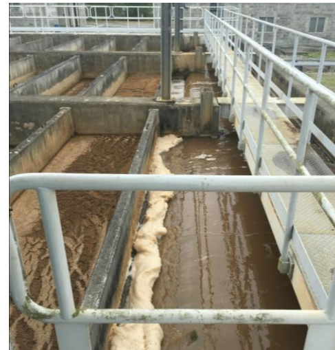
Entrada del agua a los floculadores.
