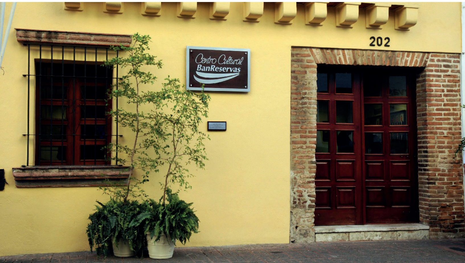
Ilustración 78: Fachada Frontal del Centro Cultural Banreserva.
