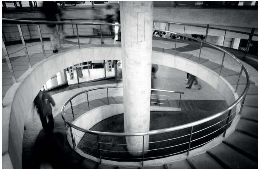
Ilustración 18: La escalera del edificio Marquês Herval, Av. Rio Branco 185, Centro, Río de Janeiro.
