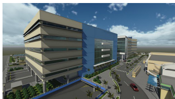
Nuevo Hospital Luis Eduardo Aybar: DN, en construcción, tipología hospitalaria polibloque.
